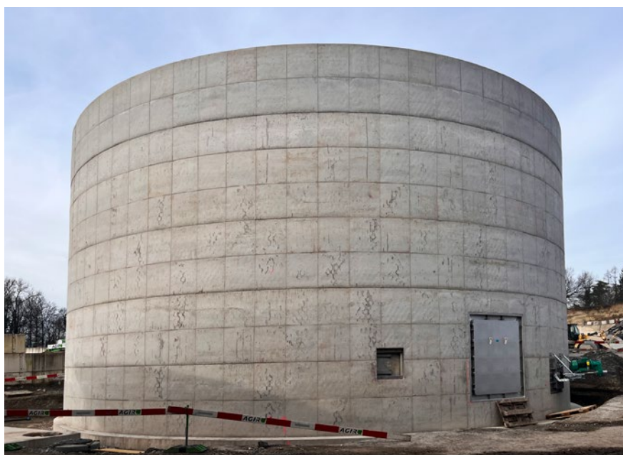
Foto 2: Neuer Nachgärer in Ottenbach im Bau. Mehrere Anlagen werden aktuell nachgerüstet. Durch einen Nachgärer kann die Verweilzeit von flüssigem Gärgut im gasdichten Raum verlängert und mehr Methan gewonnen werden. Dies verlangt unter anderem die Vollzugshilfe zur Luftreinhalte-Verordnung (LRV) bei stationären Anlagen: Cercl’Air-Empfehlung Nr. 31q. Diese Bestimmung gilt für Co- und industrielle Vergärungsanlagen.
