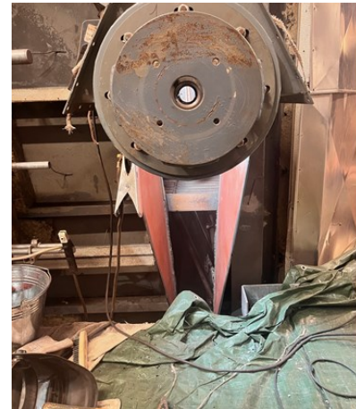
Abbildung 4: Umbau Isolatorentrommel Hammerklopfwerk E-Filter
