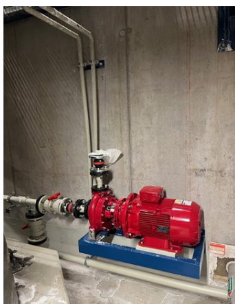
Abbildung 5: Einbau redundante ABA-Pumpe Alkaliwäscher
