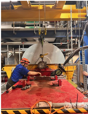
Abbildung 2: Tausch Saugzug-Lüfterrad inkl. Lager
