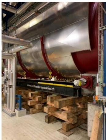
Abbildung 6: Knapp 90t um 2m verschoben und wieder zurück
