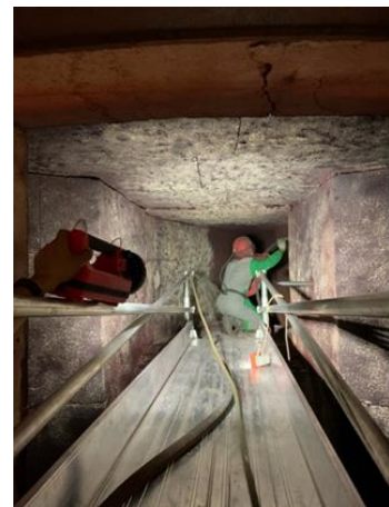
Abbildung 7: Der Übergang zwischen Ofen und Kessel wird gestrahlt
