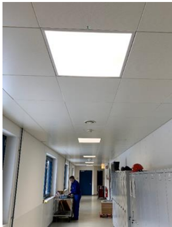
Abbildung 3: Modernisierung Beleuchtung Kopfgebäude
