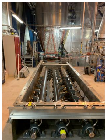
Abbildung 5: Neuer Knollenbrecher vor Montage
