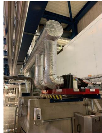
Abbildung 4: Geführte Zuluft Kransteuerung und Schubbo-den Hydraulik
