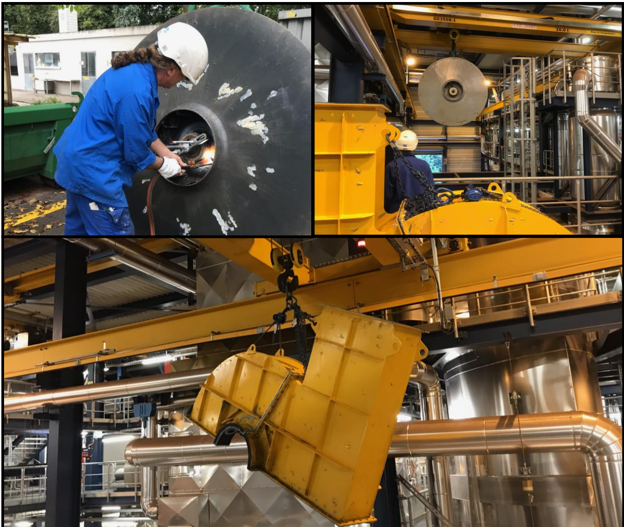
Abbildung 2: De- und Montage des Saugzug Gebläse Laufrad und Gehäuse durch die beiden Mechaniker KSV.
