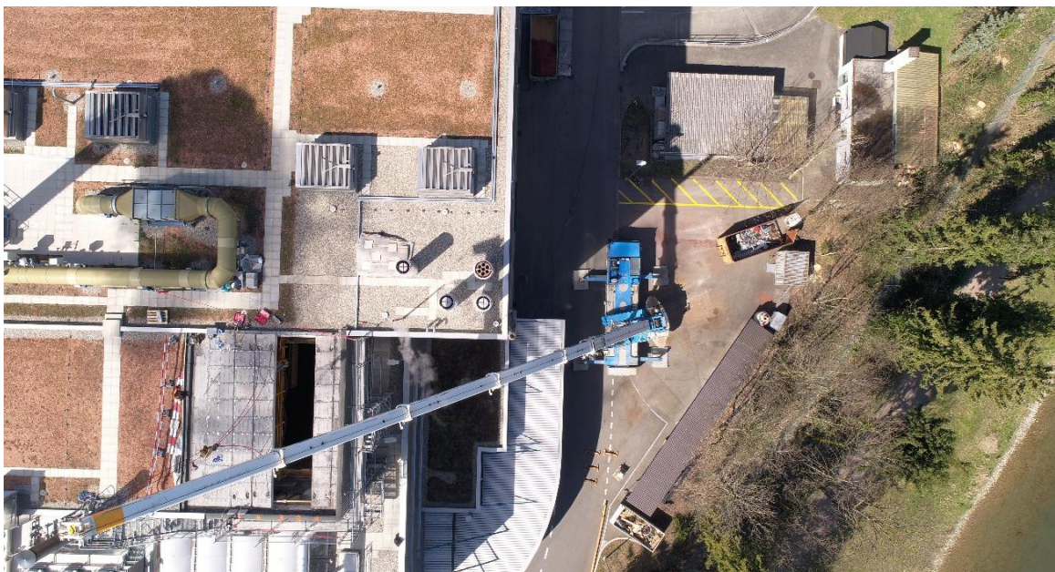
Abbildung 1: Mobilkran hebt die Betondachelemente aus ihren Lagern
