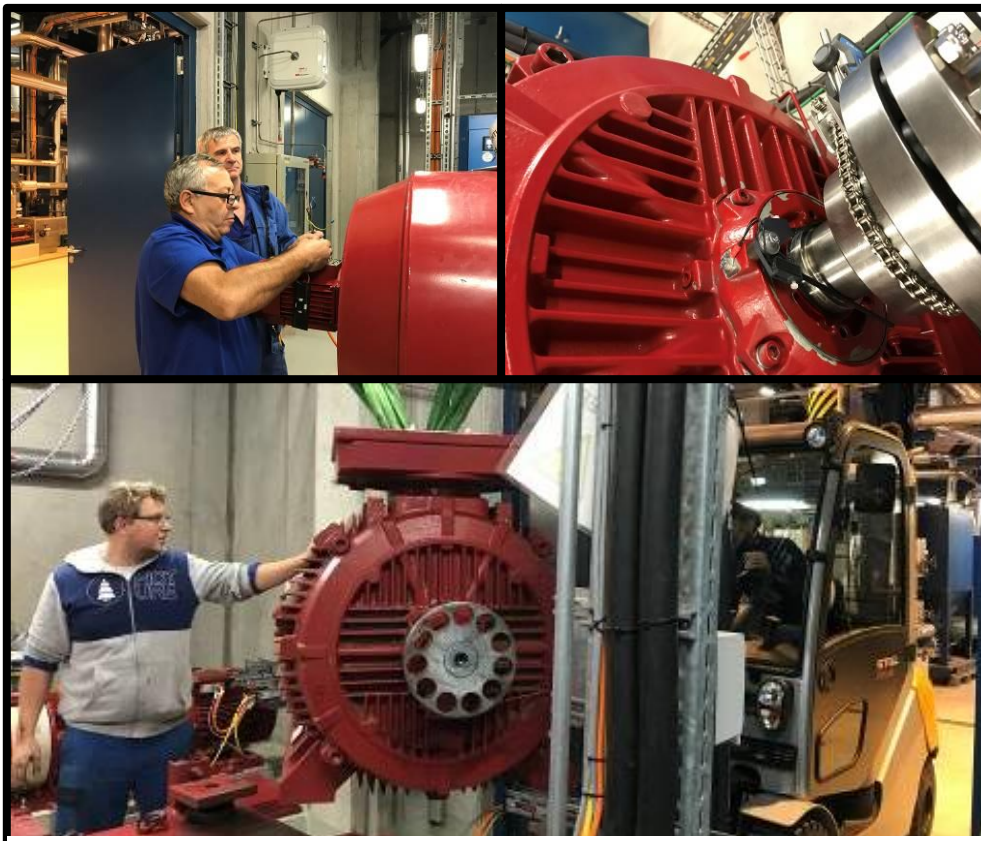
Abbildung 2: De- und Montage des Verbrennungsluftgebläse Elektromotors.
