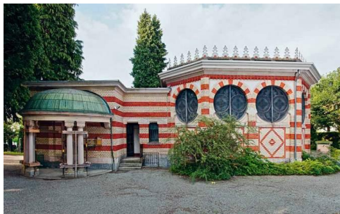
Friedhof Unterer Friesenberg: Renovierte Abdankungshalle (Denkmalgeschützt)
