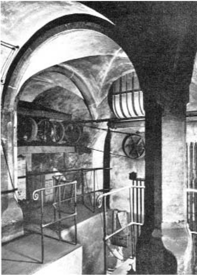
Elgg. Reformierte Kirche. Die Krypta vor der Restaurierung.
