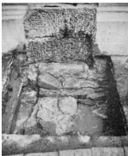
Fraumünster. Strebepfeiler zwischen Querhaus und Nordturm.
