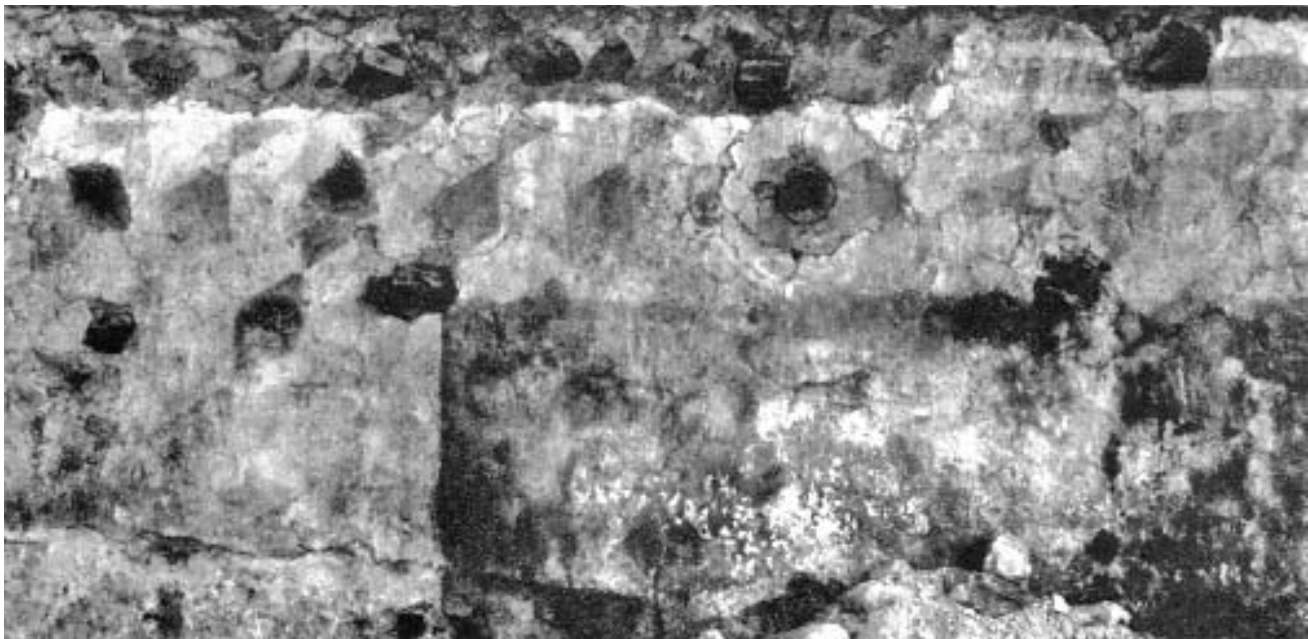
Bassersdorf. Reformierte Kirche. Südmauer des Kirchenschiffes mit Resten gotischer Sockelmalerei in Weiss und Grau (Schwarz); Wellenbandrest rechts oben orange. 1:20.
