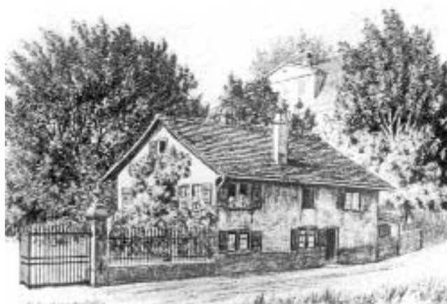
Enge, Brandschenkestrasse 52. Ansicht des jetzt abgebrochenen Hauses von Süden. Zeichnung von H. Hintermeister.
