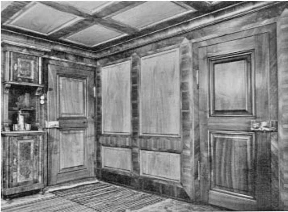
Oberrieden. Alte Landstrasse 30. Haus zur «Alten Trotte». Täferstube, vor dem Abbruch ausgebaut und im Neubau Spielhofweg 9 wieder verwendet.
