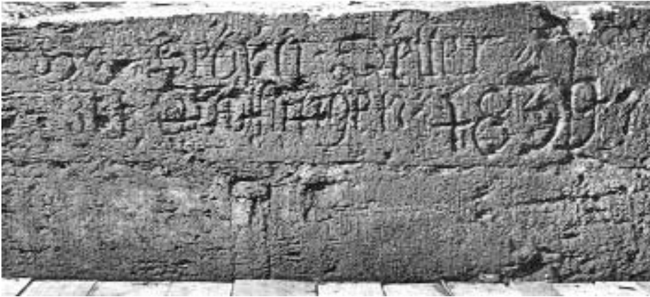
Pfungen. Gedeckte Brücke. Inschrift am nördlichen Widerlager (zu S. 81).
