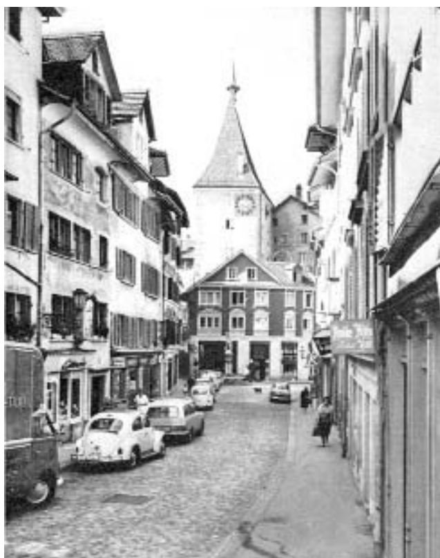
Spiegelgasse 29, Grimmenturm nach der Restauration.
