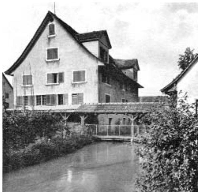
Adliswil. Sihltalstrasse Alte Mühle, abgebrochen 1965.
