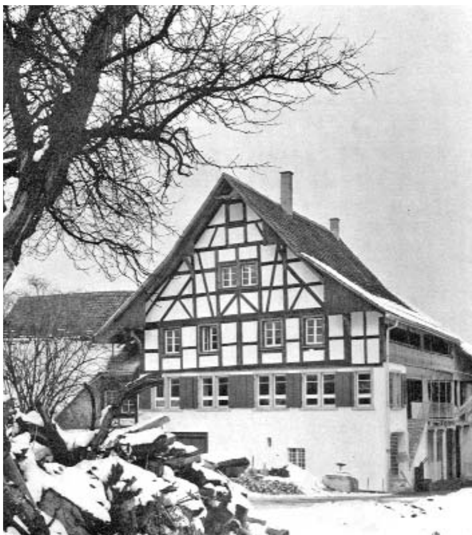
Wydlerweg 19. Mühle Albisrieden nach der Renovation.
