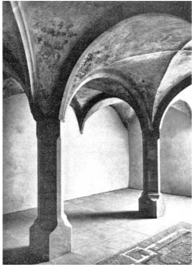
Elgg. Reformierte Kirche. Die Krypta nach der Restaurierung.
