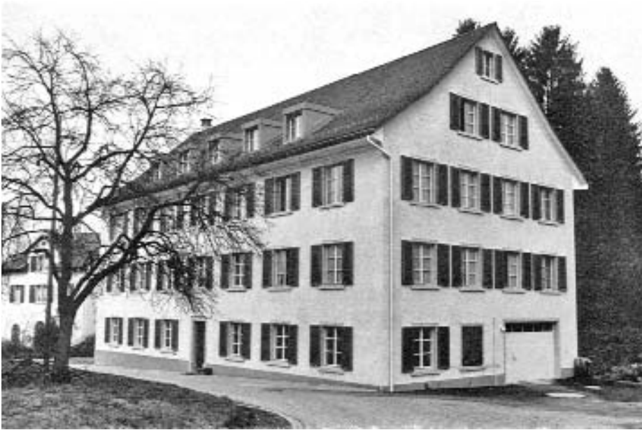
Urdorf. Ehemalige Mühle von 1860. Nach der Renovation.
