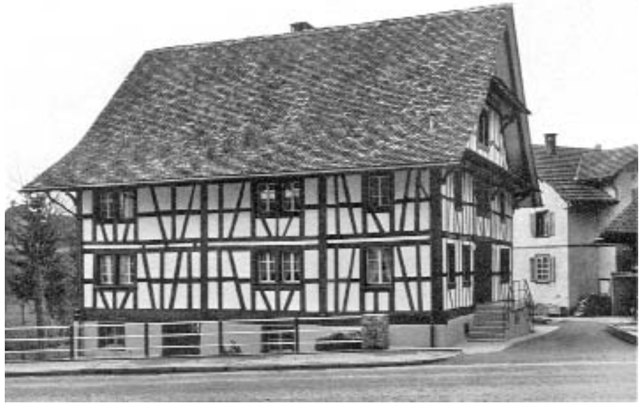
Maschwanden. Ehemaliges Untervogt- beziehungsweise Gemeindehaus. Nach der Gesamtrestaurierung 1965/66.
