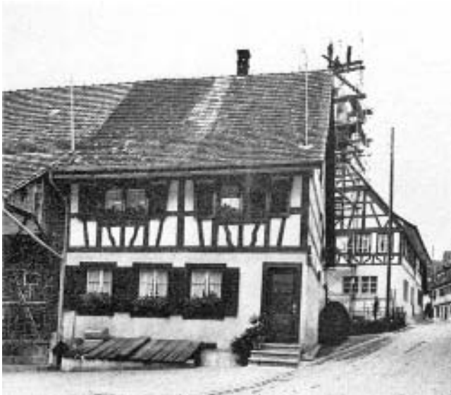
Hüntwangen. Bauernhaus Arnold Meier. Vor der Aufstockung.
