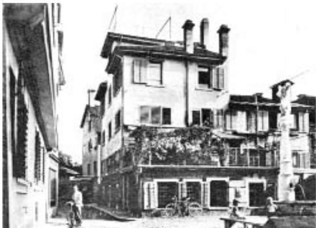
Neustadtgasse Zustand des Hauses vor der Renovation.
