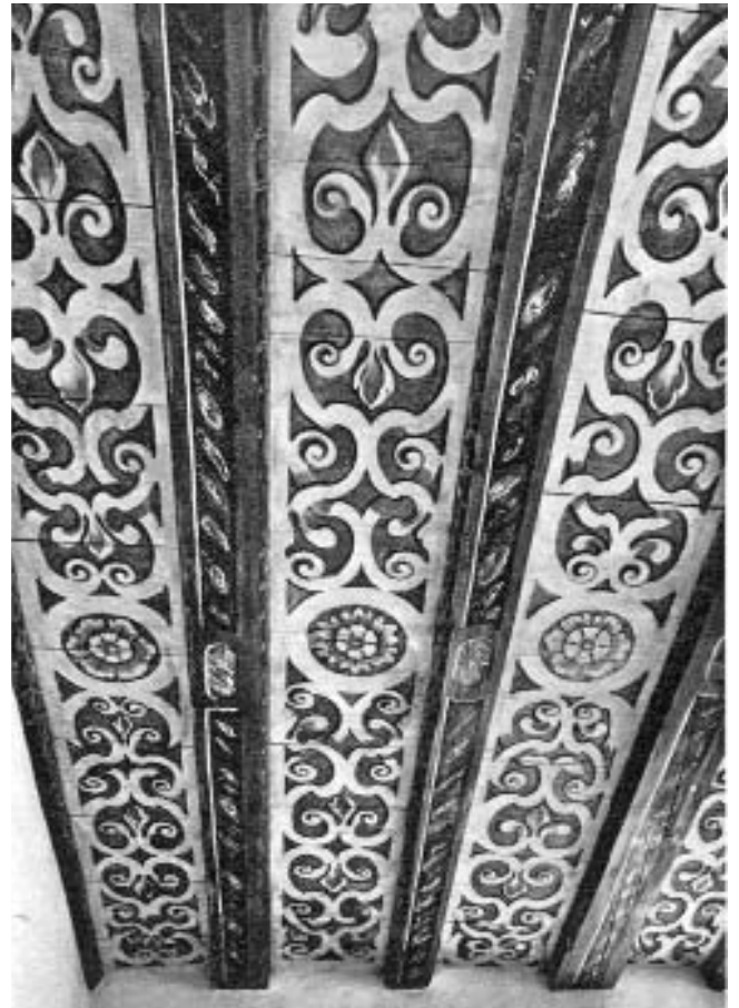
Zollikon. Seestrasse 83. Haus zum «Traubenberg». 2. Obergeschoss. Bemalte Balkendecke im grossen Salon im Westteil, nach der Restaurierung.
