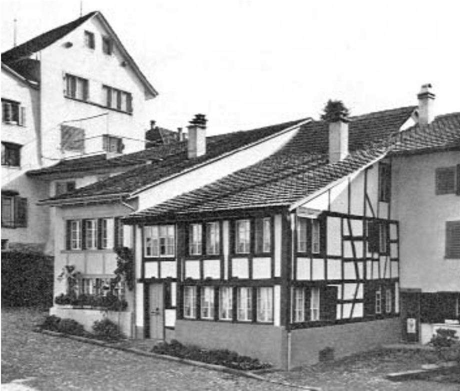
Grüningen. Chratzplatz. Riegelhaus Oberholzer, nach der Renovation (zu Seite 64).
