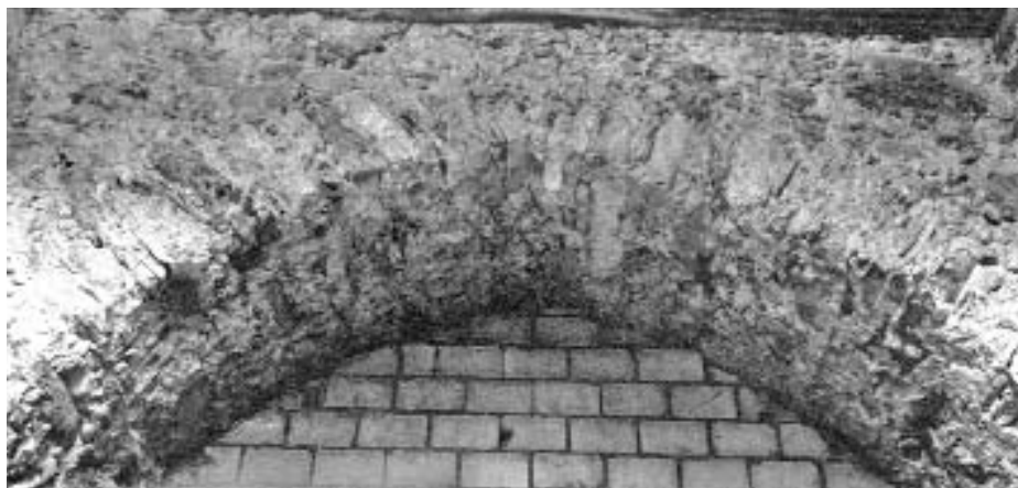
Bassersdorf. Reformierte Kirche. Chorbogen des Chorturmes, aus Osten, nach Abschlagen des Verputzes.
