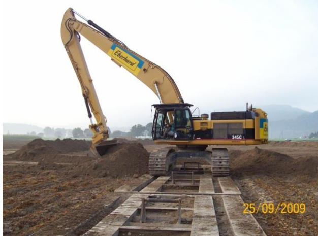
Foto: Bagger auf Stahlmatratze
