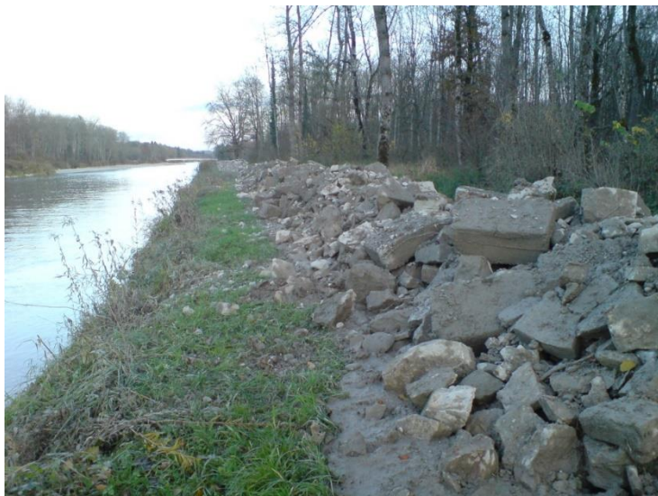
Abtrag Uferverbau. Oberhalb Thurspitz, Südufer (5.11.2009)
