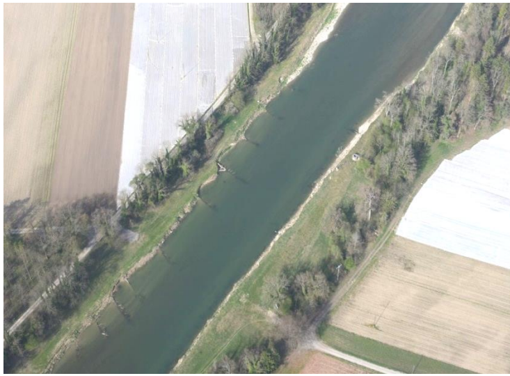
Baumbuhnen. Luftaufnahme AWEL vom 10.4.2018.
