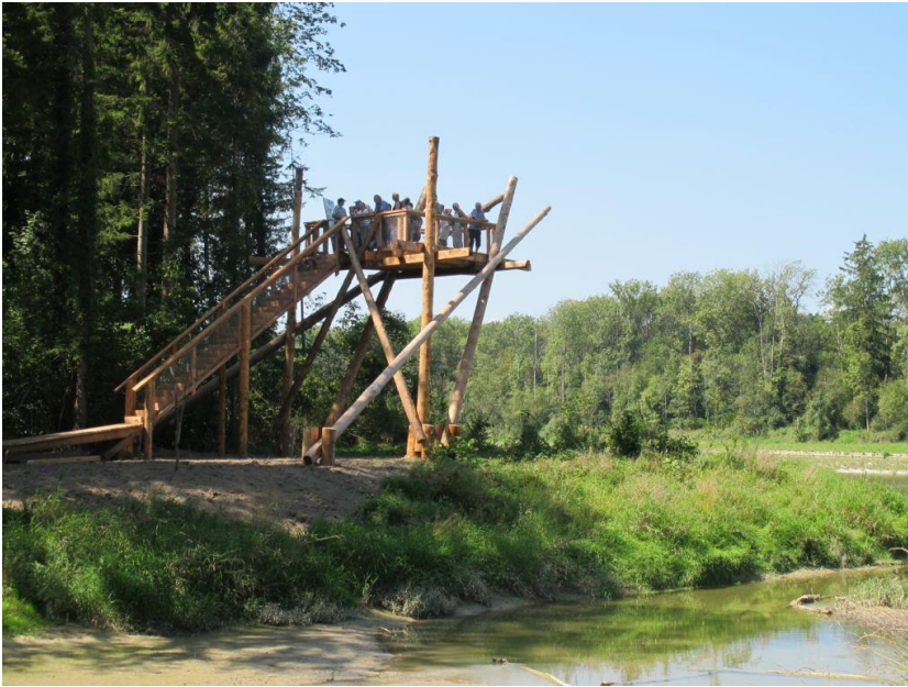
Aussichtsplattform linksufrig unterhalb Ellikerbrücke.
