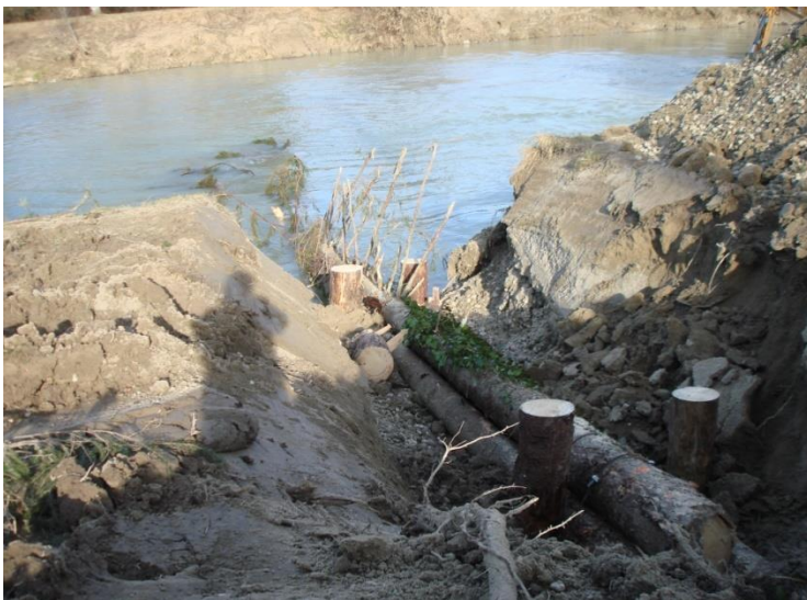
Baumbuhne im Bau. 4.2.2015
