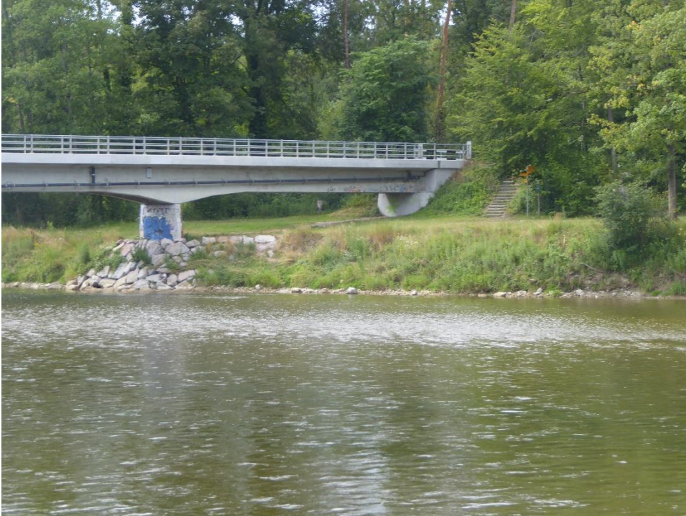
Nur teilweise sichtbarer Schutz des Pfeilers Ellikerbrücke.
