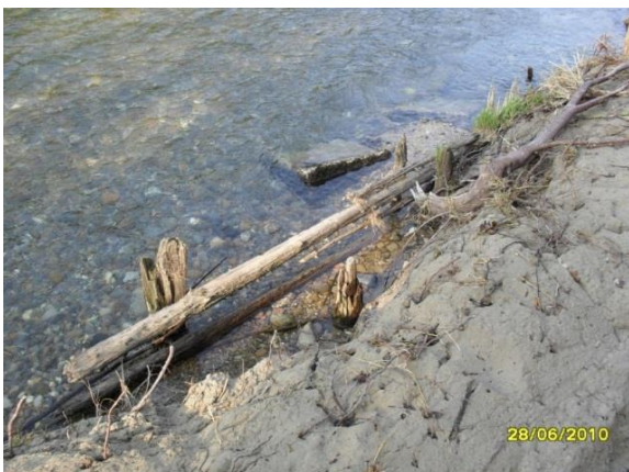
Uferbefestigungen Thur; Holzverbau
