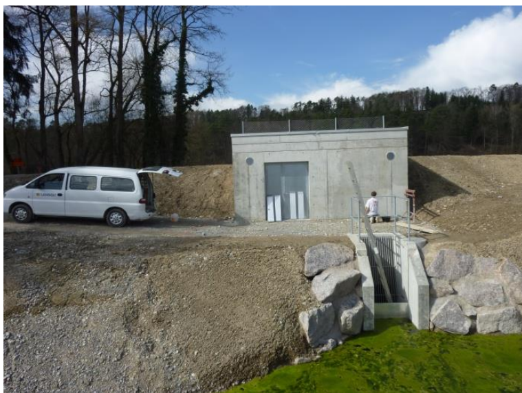
Pumpwerk Forspitz (Landseite)
