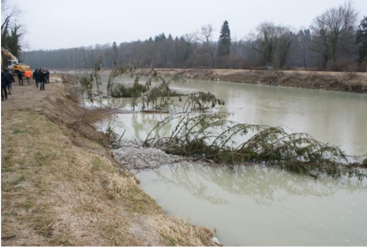
Frisch eingebaute Baumbuhnen, 17.2.2015
