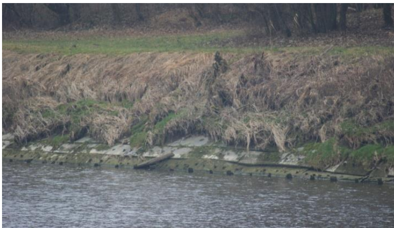
Uferbefestigung Thur; Betonplatten
