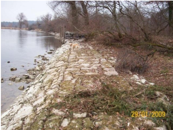
Uferbefestigungen Rhein; Blocksatz
