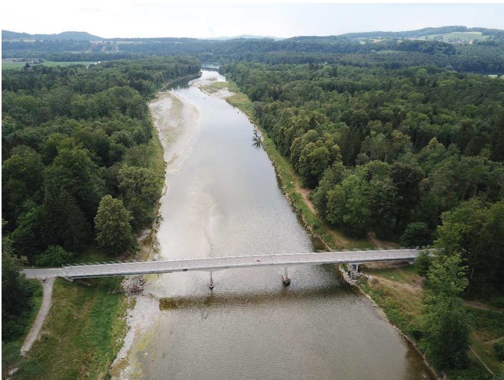
Die mittleren Pfeiler sind durch überdeckte Blockteppiche vor Pfeilerkolken geschützt.
