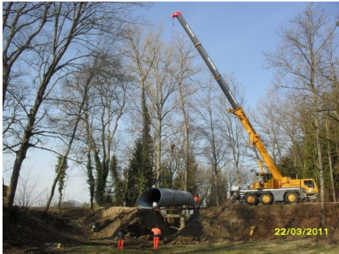
Einbau Durchlass Süd
