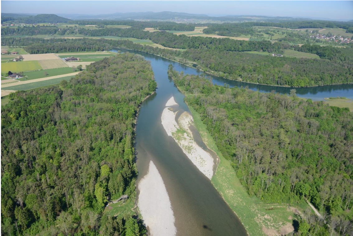
Ellikerbrücke abwärts 17.5.17 (diverse Massnahmen)
