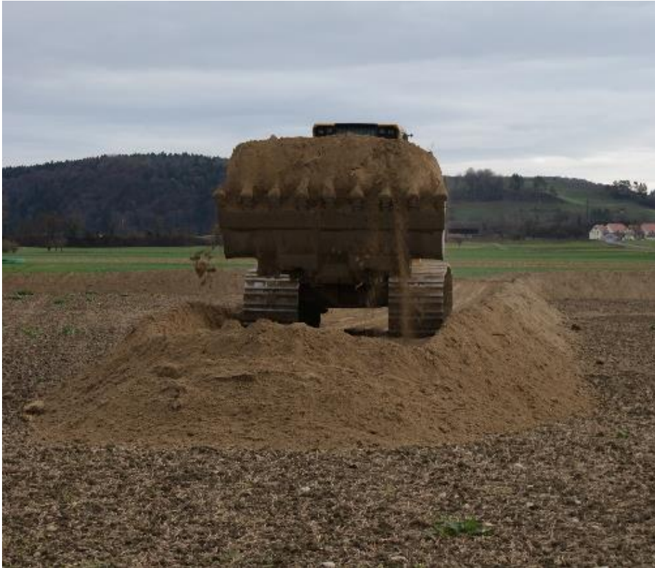
Bodenauftrag im Flaacherfeld, 16.12.2014
