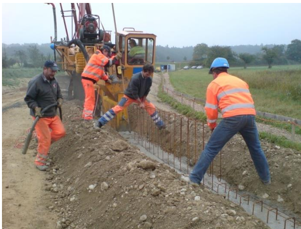
Erstellung der Dichtwand mit Grabenfräse, nördlich des Dorfkerns.
