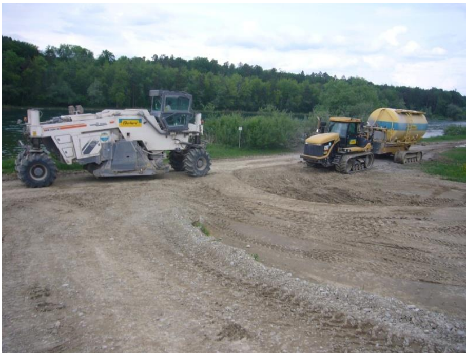
Dammbauarbeiten Forspitz. Das Material aus den Thurauen wurde mit Zement stabilisiert
