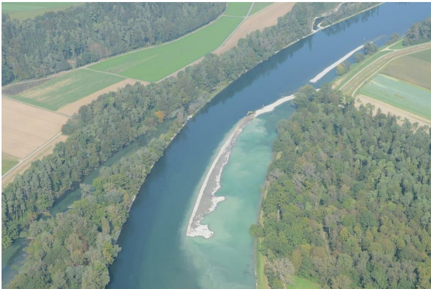
Baggerung an der Thurmündung. 27.9.2016, Foto M. Federer AWEL
