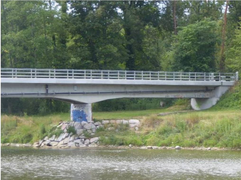
Versteckte Widerlagersicherung Ellikerbrücke
