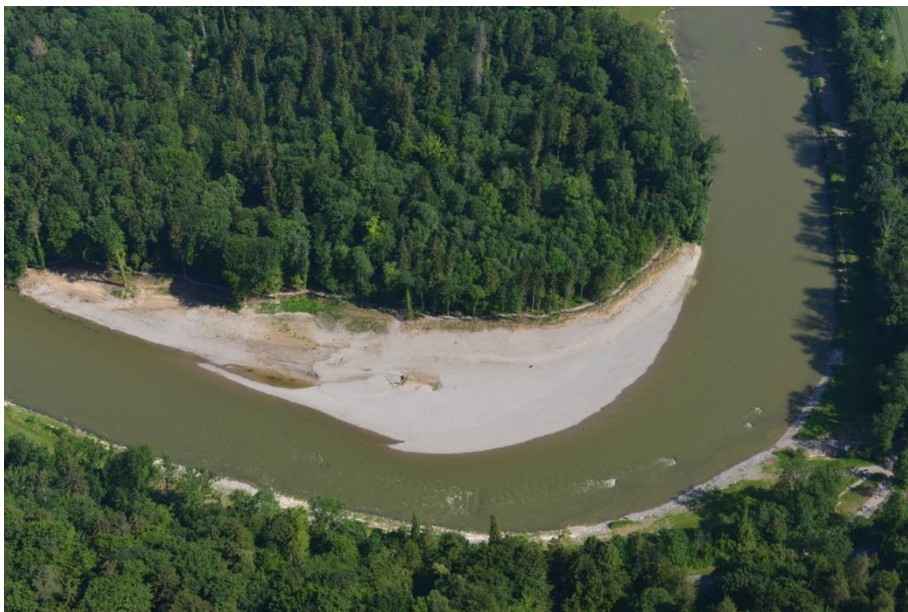
Eggrank nach dem Umbau. Flugaufnahme AWEL 17.6.2015. Die Lage der Buhnen ist nur teilweise an der gekräuselten Wasseroberfläche zu erkennen.
