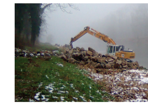
Entfernung Längsverbau im Neugrüt.
