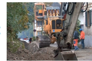
Einbau der Betondichwand in Ellikon am Rhein.
