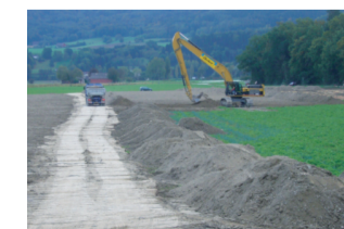
Bodenverbesserungen im Flaacherfeld: Verwertung von ausgebaggertem Erdmaterial.
