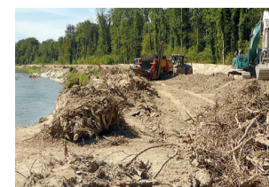
Ausbaggerungen und Materialaufbereitung für die Flussaufwertung Wannemacher.
