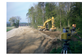
Bau eines neuen Hochwasserschutzdamms beim Forstspitz.
