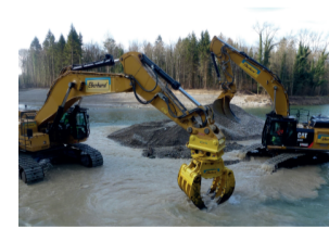
Arbeiten am Eggrank für die Renaturierung.
