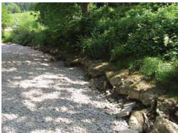
Bild 22 Töss, Oberwasser der erodierten Schwelle in Bild 5.20. Der Uferschutz ist infolge der Sohlenerosion unter-spült.
