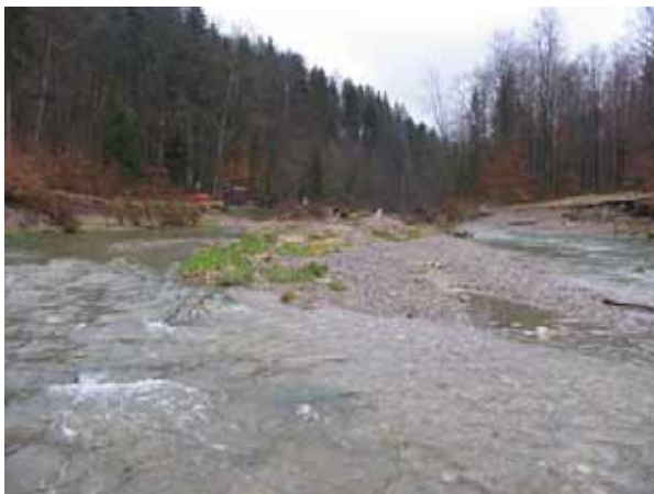
Bild 63 Töss, Mittlere Au (km 21.15). Künstliche Insel als Initialmassnahme zur Förderung von Ufererosionen. Blick gegen Fliessrichtung.
