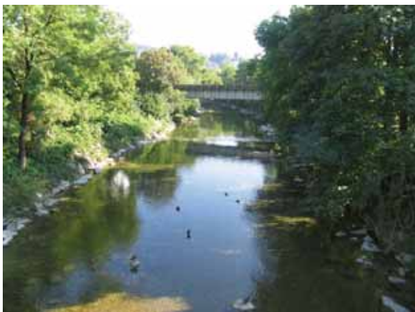
Bild 74 Töss, Winterthur-Töss, ab Brücke Nägelseestrasse (km 16.73). Kanalisier-tes Gerinne mit hart verbauten Ufern. Blick in Fliessrichtung.
