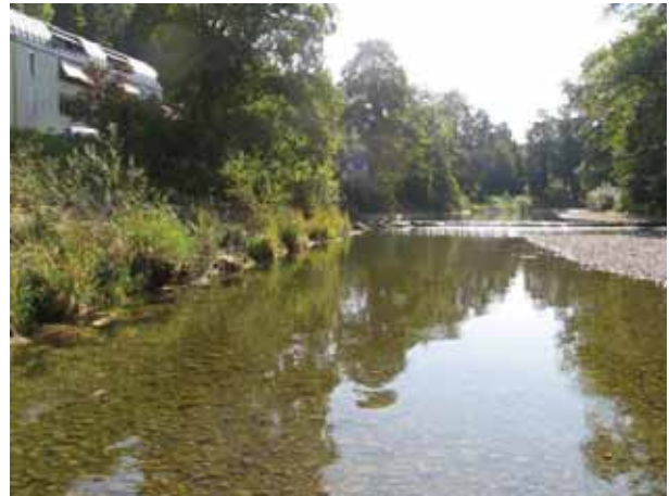
Bild 77 Töss, Schlosstal Winterthur (km 15.8). Kanalisiertes Gerinne mit hart verbauten Ufern. Blick gegen Fliessrichtung.
