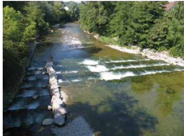
Bild 111 Töss, Rorbas/Freienstein, ab Bogenbrücke (km 99). Im Unterwasser der Schwellenkaskade wurde die Sohle im Rahmen eines Hochwasserschutzprojektes abgetieft.
