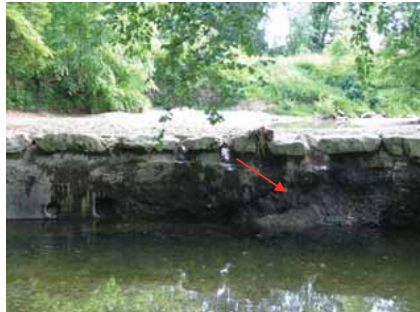
Bild 25 Töss, Steg. Schwelle nach Einmündung Fuchslochbach (km 50.013). Die Krone der auf Fels aufgesetzte Schwelle (Pfeil) zeigt ausgeprägte Abriebspuren.
