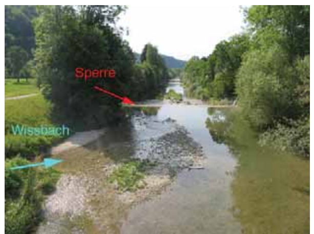
Bild 53 Töss, Kollbrunn, ab Brücke Weisslingerstrasse (km 26.92). Geschiebeablagerungen vor einer rund 3m hohen Sperre im Bereich der Wissbachmündung. Blick in Fliessrichtung.
