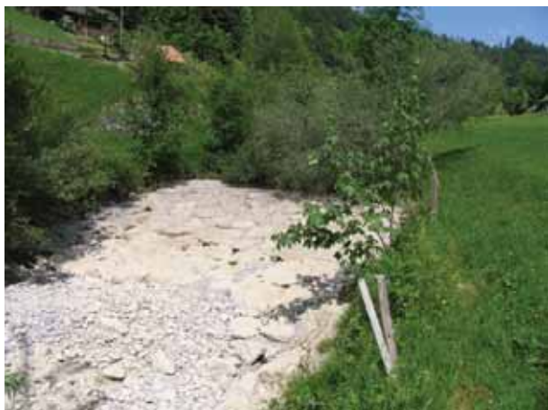
Bild 18 Töss, flussaufwärts Skilift Steg, km 51.2. Kürzlich sanierte Schwelle mit erhöhter Überfallkrone.
