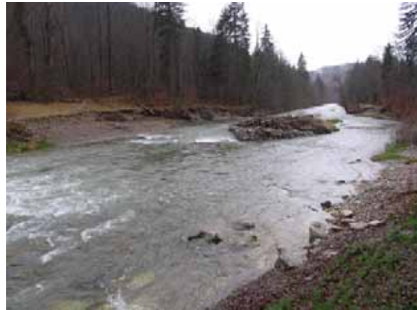
Bild 62 Töss, Mittlere Au (km 21.15). Künstliche Insel als Initialmassnahme zur Förderung von Ufererosionen. Blick in Fliessrichtung.
