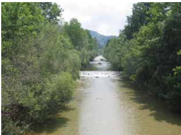
Bild 39 Töss, Saland ab Fussgängersteg ARA (km 40.111). Blick gegen Fliessrichtung. Die Sohle zwischen den Schwellen ist eben und auch bei kleinen Abflüssen vollständig benetzt.
