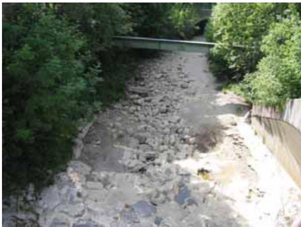
Bild 28 Töss, unteres Ende der Unterquerung Tösstalstrasse. Die Sohle ist mit grossen Blöcken angereichert. Blick in Fliessrichtung.
