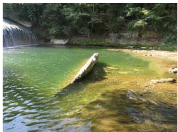
Bild 81 Töss, Wasserfassung Wäspi-Mühle bei Wülflingen (km 14.366). Unterholzte und abgekippte Felsplatte im Unterwasser des Wehrs.
