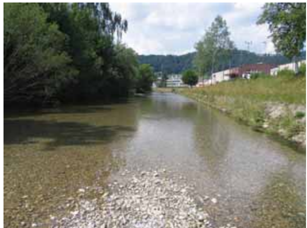
Bild 44 Töss, Turbenthal bei km 34.6. Die ebene Sohle ist auch bei kleinen Abflüssen weitgehend benetzt. Blick in Fliessrichtung.
