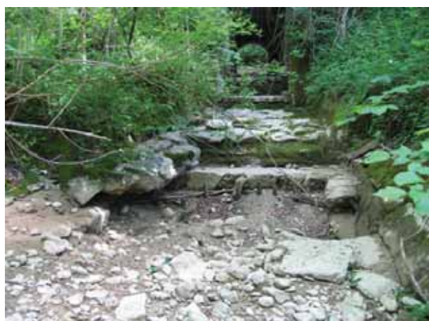
Bild 16 Brüttenbach, Abschnitt zwischen Strassenbrücke und Mündung. Wegen dem Geschieberückhalte ist die Bachschale weitgehend zerstört.
