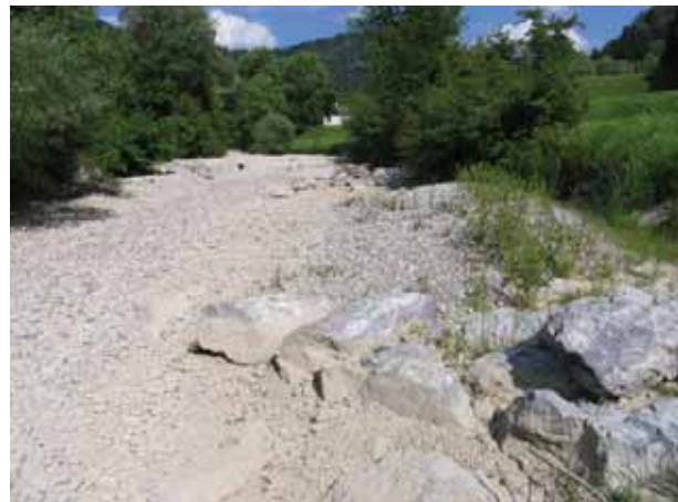
Bild 29 Töss, Höhe Werkhof Forstverwaltung Staatswald (km 48.6). Versuchsstrecke mit Buhnen zur Strömungslenkung gegen das rechte Ufer. Blick gegen Fliessrichtung.
