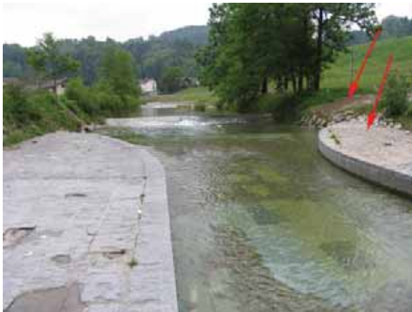
Bild 33 Töss, Altlandenberg (km 40). Blick gegen Fließrichtung. Aufgrund der Querschnittseinengung bei der Messstation ergeben sich im Oberwasser Geschiebeablagerungen, die periodisch entnommen werden. Pfeile: Spuren der letzten Entnahme.
