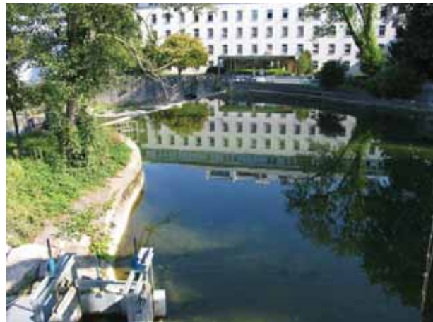
Bild 71 Wehranlage Rieter AG (km 17.3). Bei Hochwasser werden die 1m hohen Wehrklappen abgesenkt. Blick in Fliessrichtung.
