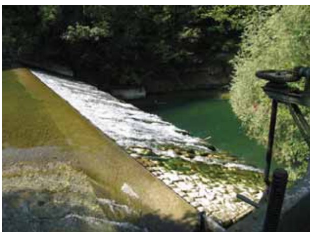
Bild 80 Töss, Wasserfassung Wäspi-Mühle bei Wülflingen (km 14.366). Die gemauerte Wehrschwelle mit aufgesetzter beweglicher Klappe ist auf einem die Töss querenden Felsband aufgesetzt.
