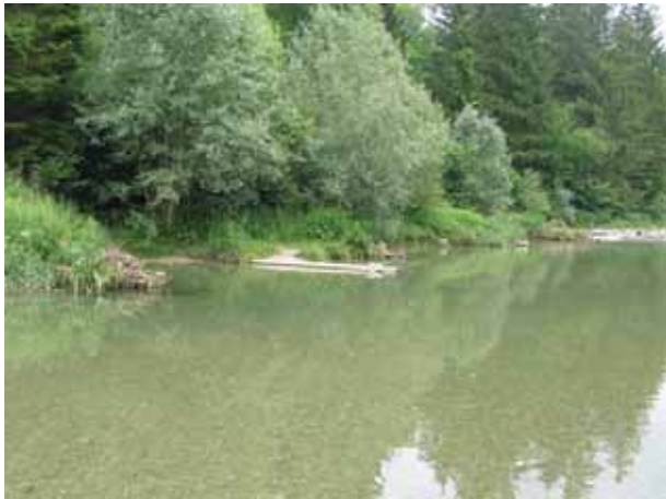
Bild 61 Töss, Leisental (km 2.2). Strukturierung und Schutz des Ufers mit Baum-buhnen. Im Vordergrund sind unter Wasser Geschiebeablagerungen zu erkennen.
