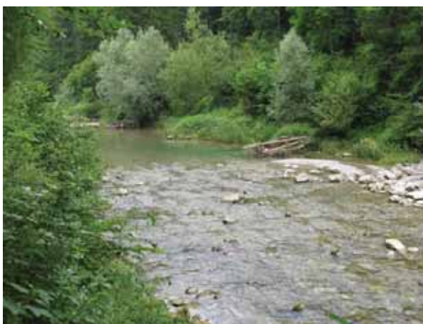
Bild 59 Töss, Leisental (km 2.2). Blockrampe als Ersatz für die ursprünglichen Steinmantelsperren. Blick in Fließrichtung.
