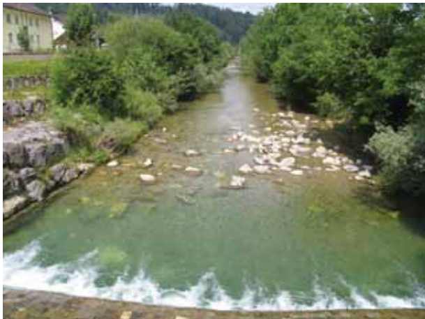
Bild 37 Töss, Dillhus ab Brücke Haslehaldenstrasse (km 42.014). Lokale Sohlenanreicherung mit grossen Blöcken.
