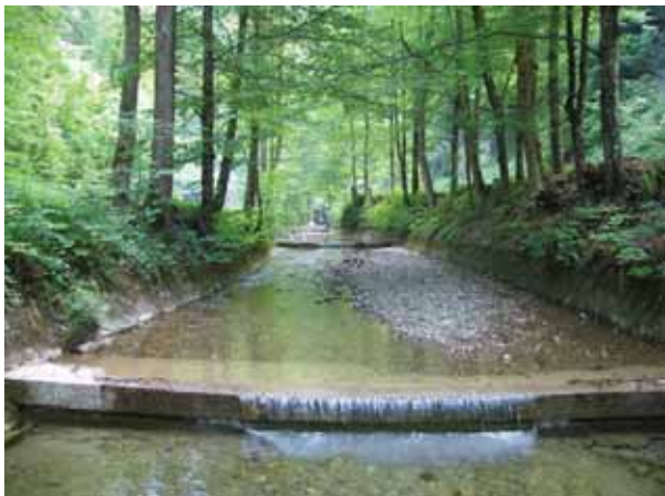
Bild 5 Hintertöss mit hart verbauten Ufern und Sohlschwellen. Blick gegen Fliessrichtung.
