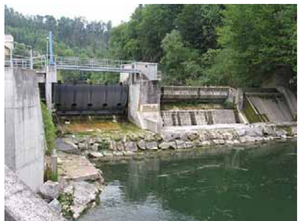
Bild 109 Töss, Kraftwerk Freienstein. Umbau 2004. Wehr mit drei Feldern, wobei zwei davon mit Stauklappen versehen sind, die bei Hochwasser abgesenkt werden (Feld 1 BxH=8.8x 4m, Feld 2 BxH= 12.05x2.2m).
