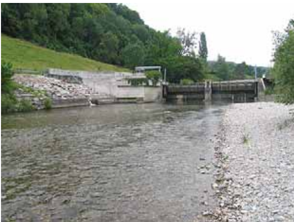
Bild 101 Kraftwerk Pfungen (km 9.8), Blick gegen Fliessrichtung. Neubau 1992. Die Stauklappen (BxH = 10x2.35m) werden bei Hochwasser abgesenkt.
