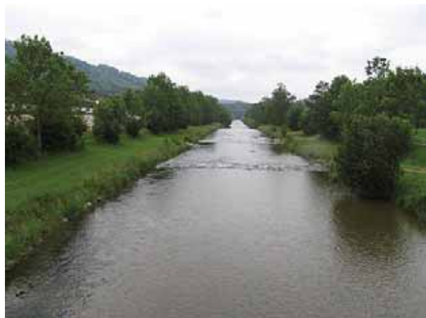
Bild 102 Töss Pfungen, Blick ab Brücke Blumetshalde (km 9.45). Begradigtes Gerinne mit hart verbauten Ufern und Blockschwellen.
