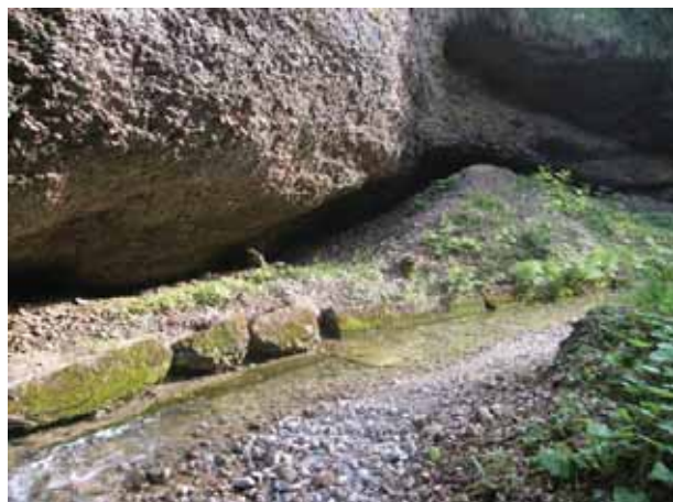
Bild 4 Vordertöss, lokaler Uferverbau entlang einem Nagelfluhfels.
