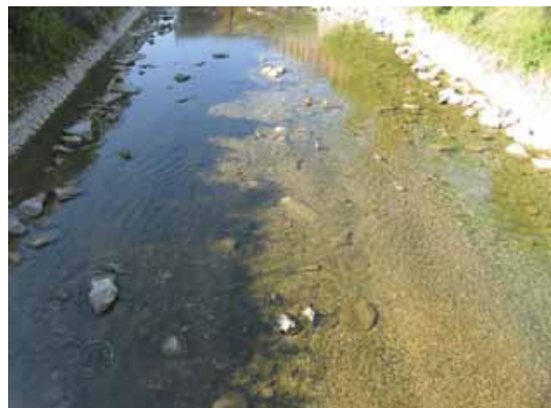
Bild 75 Töss, Winterthur-Töss, ab Brücke Nägelseestrasse (km 16.73). Die Sohle ist mit einzelnen Blöcken angereichert und stellenweise mit Geschiebe überdeckt.
