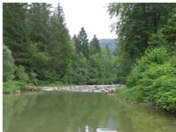
Bild 60 Töss, Leisental (km 2.2). Blockrampe aus Bild 5.55 und stehendes Wasser aufgrund des Rückstaus durch die unterliegende Schwelle.
