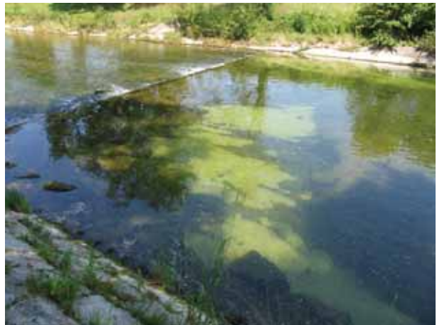
Bild 100 Töss, Neftenbach (km 10.7). Flussabwärts der Messstation Neftenbach ist die Kiessohle bis auf den Lehmuntergrund erodiert.
