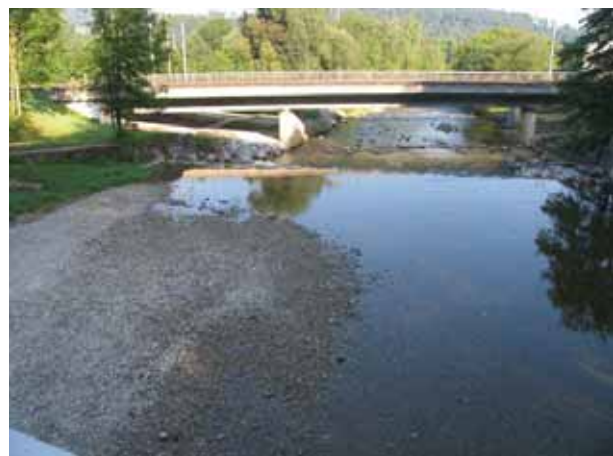
Bild 66 Töss, Reitplatz Winterthur (km 18.05). Geschiebeablagerungen entlang dem Gleithang vor einer 2.2m hohen Schwelle. Blick in Fliessrichtung.
