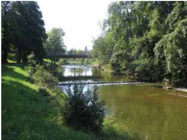
Bild 76 Töss, Schlosstal Winterthur (km 15.8). Kanalisiertes Gerinne mit hart verbauten Ufern. Blick gegen Fliessrichtung.
