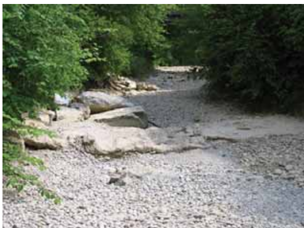
Bild 20 Töss, erodierte Schwelle unterhalb der Zufahrtsbrücke zum Skilift Steg, km 51.05.
