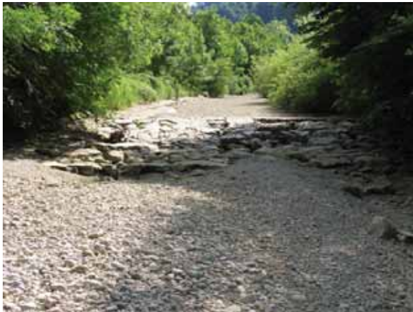
Bild 24 Töss, Steg. Baufällige Schwelle töss-aufwärts der Brücke Tösstalstrasse (km 50.205).
