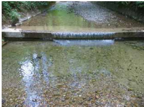
Bild 6 Hintertöss, Blick gegen Fliessrichtung. Im Unterwasser der Schwelle ist die aufgeschlossene Nagelfluh zu erkennen.
