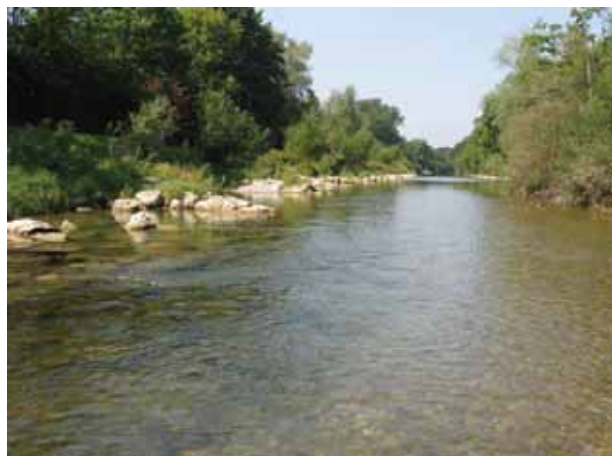
Bild 96 Töss, Tössallmend Neftenbach (km 11.8). Im Rahmen der Aufwertung 1994 erstellte Blockbuhnen. Blick in Fliessrichtung.
