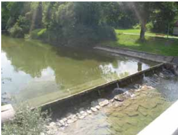
Bild 50 Töss, Au/Rikon (km 28.9). Wasserfassung der H. Bühler AG mit Wehrklappen, die bei Hochwasser abgesenkt werden.
