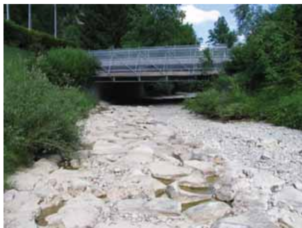
Bild 23 Töss, Steg. Brücke Tössstalstrasse vor Einmündung Fuchslochbach, km 50.15. Massiver Kolkschutz aus Blöcken entlang dem Prallhang.
