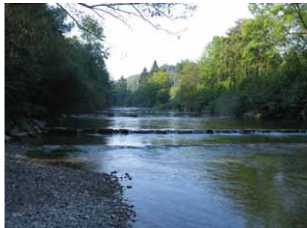
Bild 64 Töss, Reitplatz Winterthur (km 18.9). Begradigtes Gerinne mit Holzschwellen und hart verbauten Ufern. Blick gegen Fliessrichtung.
