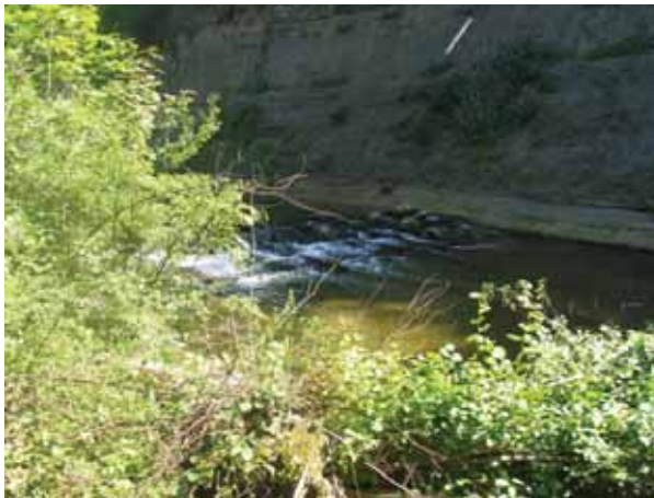
Bild 106 Töss, Dättlikon, Bereich Talmäander (km 7.4). Mehrere, teilweise vor wenigen Jahren gebaute Blockrampen schützen die Sohle gegen Erosion.
