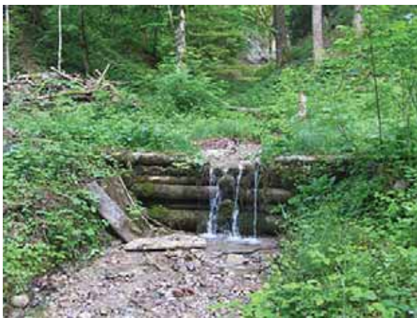
Bild 3 Vordertöss, mit Geschiebe hinterfüllte Holzschwelle.
