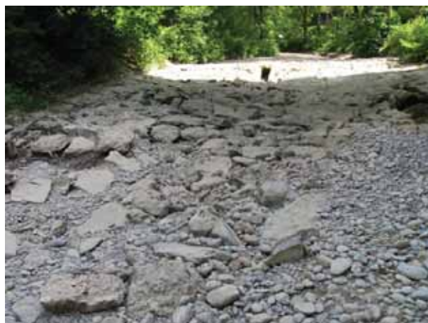
Bild 21 Töss, Schwelle tössaufwärts Bild 5.20. Aufgelöster Rampenfuss aufgrund Sohlenerosion.
