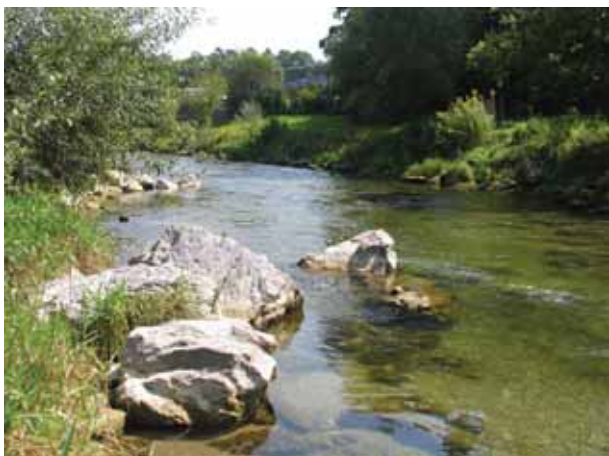
Bild 95 Töss, Tössallmend Neftenbach (km 11.8). Im Rahmen der Aufwertung 1994 erstellte Blockbuhnen zur Uferstrukturierung. Blick gegen Fliessrichtung.
