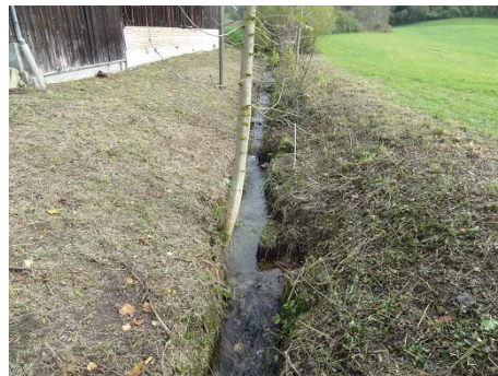
Abbildung 5 Jonenbach oberhalb von Hausen am Albis, beim Bad (Blick gegen die Fließrichtung)
