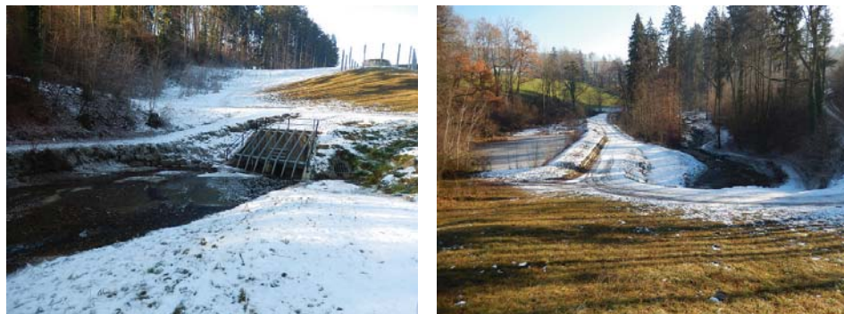
Abbildung 12 Hochwasserrückhaltebecken oberhalb von Affoltern a.A. (links, Blick in Fließrichtung, rechts, Blick gegen die Fließrichtung)
