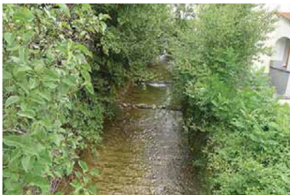
Bild 30 Kanalisierter Wildbach mit gepflasterter Sohle und hart verbautem Böschungsfuss in Hinwil. Blick gegen die Fliessrichtung.
