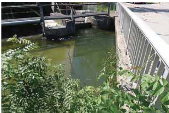
Bild 48 In die Sohle eingelassene Geschiebeabzugsrinne vor dem Einlauf in den Oberwasserkanal (rechts, unter Brücke) mit Spülschütz ins Unterwasser Hintergrund.
