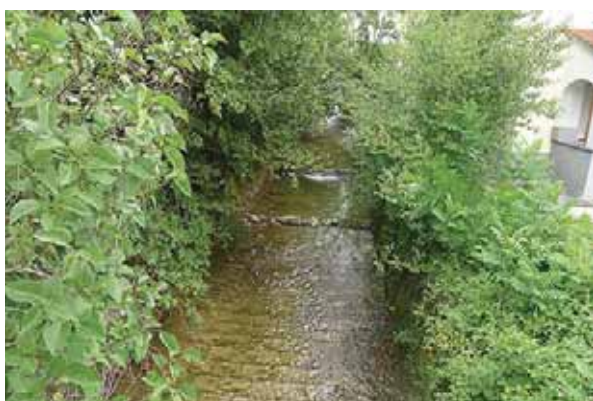
Bild 10 Kanalisierter Wildbach mit gepflasterter Sohle und hart verbautem Böschungsfuss in Hinwil. Blick gegen die Fliessrichtung.
