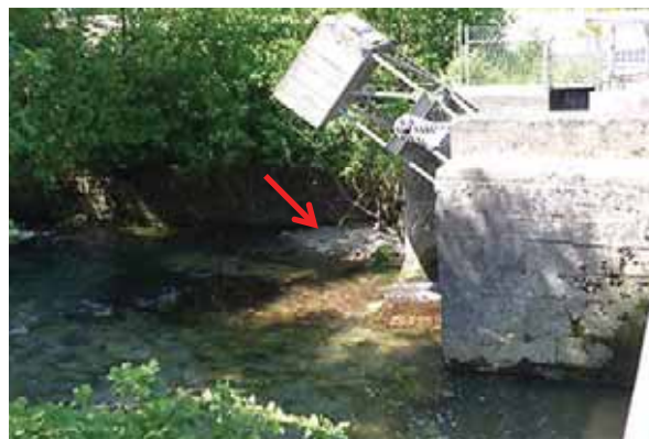
Bild 49 Geschiebeablagerungen im Unterwasser des Geschiebeabzugs (Pfeil) zeigen, dass die Anlage für Geschiebe durchgängig ist. Fliessrichtung von rechts nach links..
