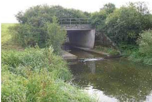
Bild 36 Auslauf des Durchlasses mit Absturz in das tiefer liegende Gerinne im Unterwasser.
