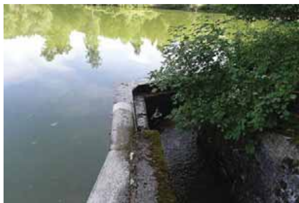
Bild 5 Das zufließende Wasser wird über die Hochwasserentlastung ins Unterwasser abgegeben.
