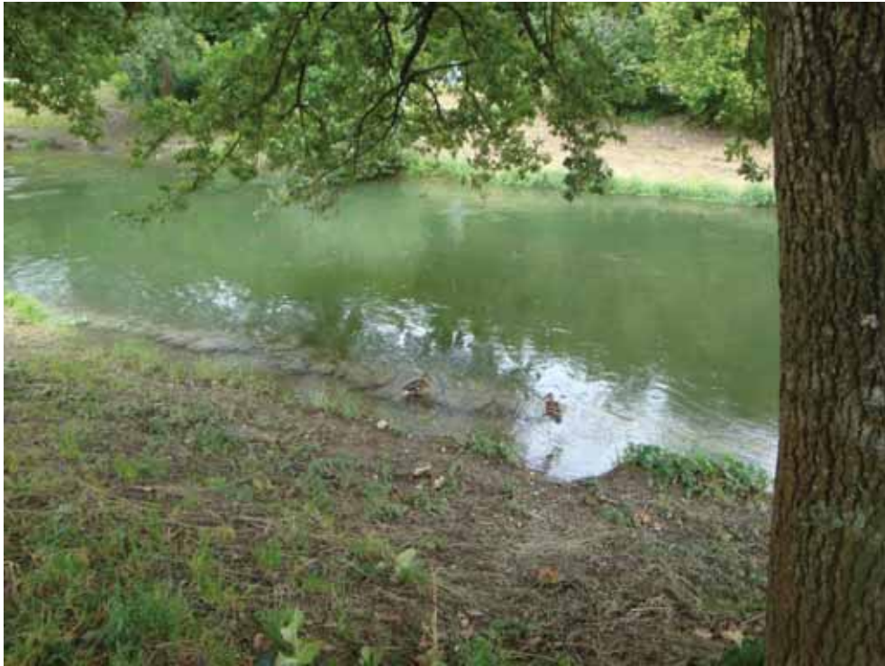
Bild A.3.5: Erosionsschaden hinter Blocksatz (GEWISS km 28.1)
