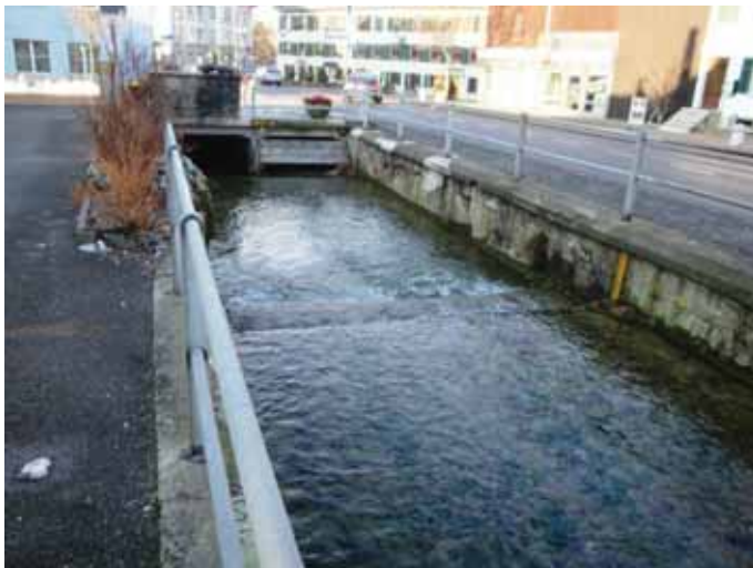
Bild A.1.10: Altbach beim Kreisel in Bassersdorf. Bereich Gefällsknick, wo regelmässig Geschiebe entnommen wird (Zustand Januar 2009)
