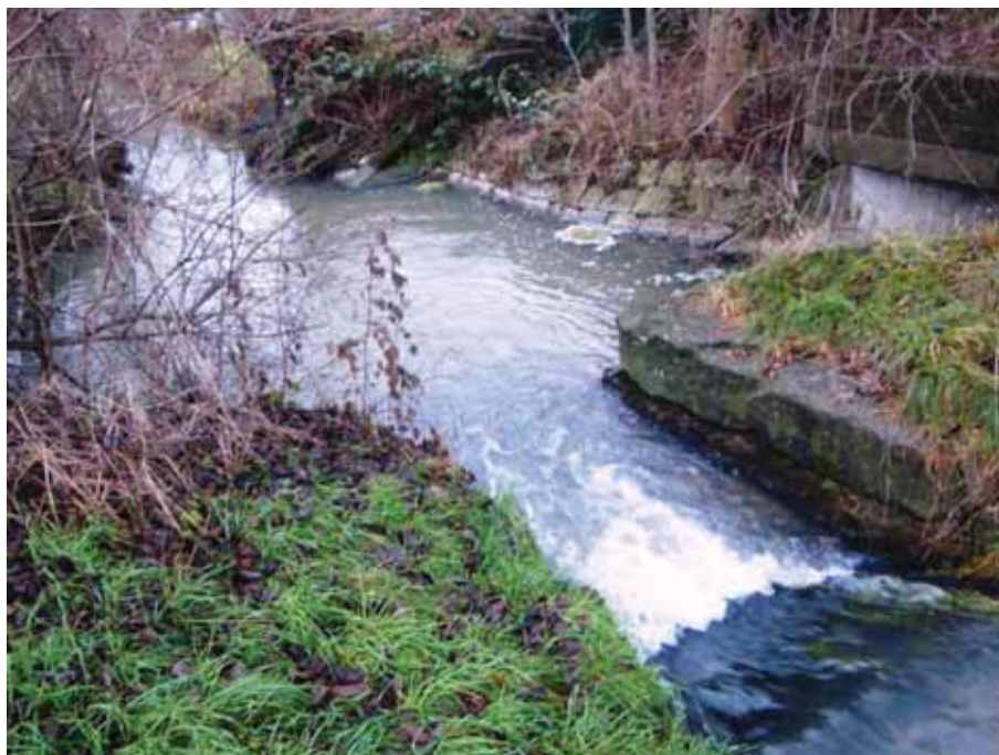
Bild A.2.9: Surb in Oberwenigen nach Durchlass unter Bahnlinie. Einmündung eines Regenauslasses aus der Kanalisation. Nach dem Einlauf ist das Profil grösser und die Sohle tiefer, was den Einbau einer Schwelle erforderte
