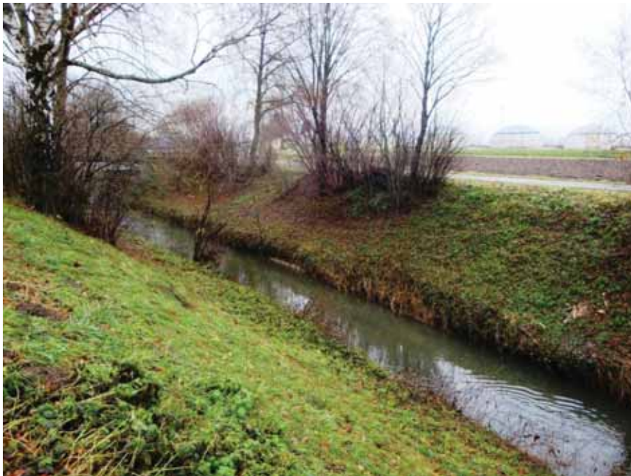
Bild A.2.2: Furtbach bei Watt. Künstliches abgesenktes Gerinne mit Sandsohle
