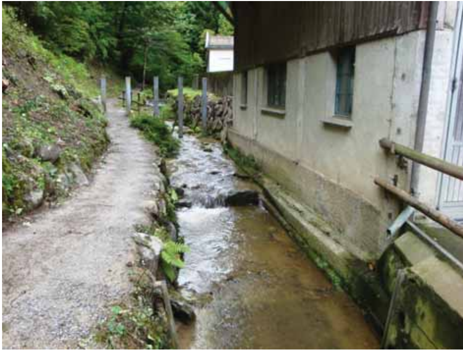
Bild A.1.3: Verbauter Abschnitt am Kegelhal mit Schwemmholzrechen, unmittelbar oberhalb Eindolung
