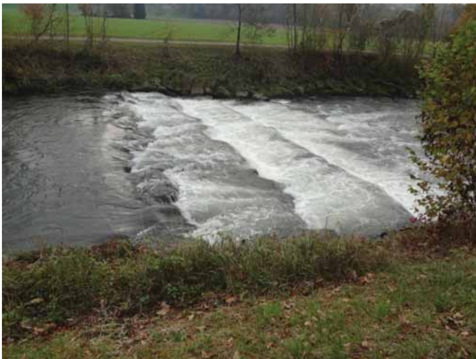
Bild A.3.8: Verbauung der Glatt im Unterlauf, Sperrentreppe (GEWISS km 1.6)
