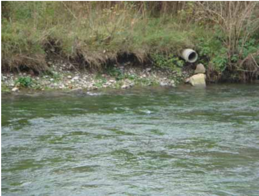
Bild 18: Unterhalb des Trennbauwerks wurde der Uferverbau entfernt, was eine gewisse Seitenerosion ermöglicht
