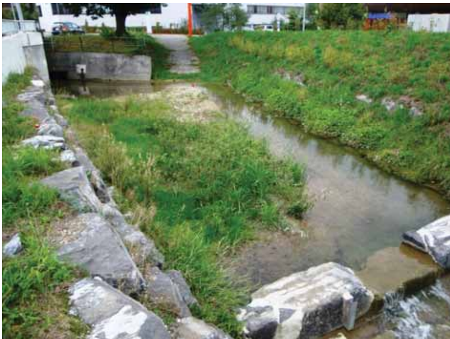
Bild A.1.4: Geschiebesammler nach der Eindolung
