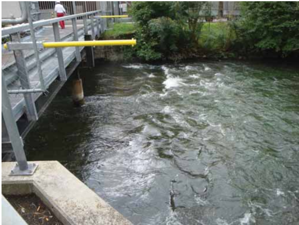
Bild A.3.23: Niedere Blockschwelle unterhalb Wehr Memphis (GEWISS km 30.5)
