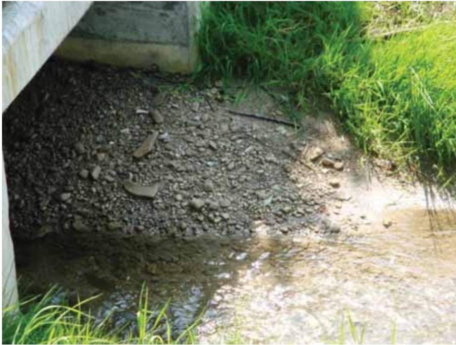
Bild A.2.13: Dorfbach Niederwenigen, Geschiebebank im Auslauf der Eindolung
