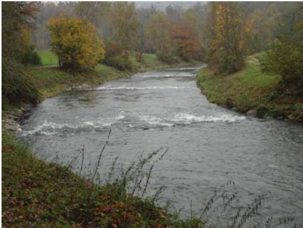
Bild A.3.7: Verbauung der Glatt im Unterlauf, mit Traversen in engem Abstand (GEWISS km 6.5)
