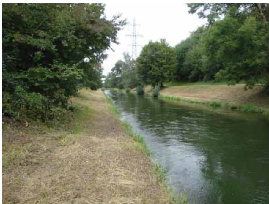
Bild A.3.4: Typisches Profil der Glatt, Blocksatz unter Wasser, teilweise mit Gras überwachsen; gerade nach Unterhaltsschnitt (GEWISS km 28.1)
