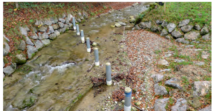
Einlaufrechen Auslikerbach, Pfäffikon/Unter Balm (links) und Schwemmholzrechen Wissenbach, Bauma (rechts)
