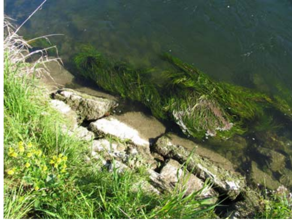
Verschobene Quadersteine bilden Angriffsstellen für die Strömung.
