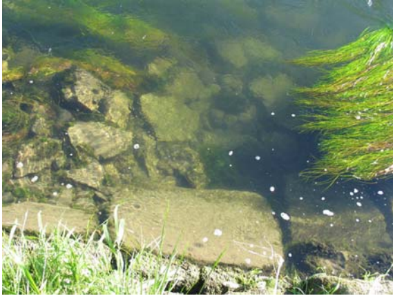
Einzelne Quadersteine erodiert.
