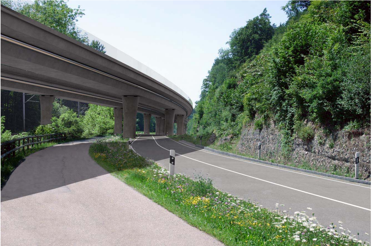
Der Grosse Viadukt der geplanten Oberlandautobahn im Aathal, welcher das Landschaftsbild verändern wird.
