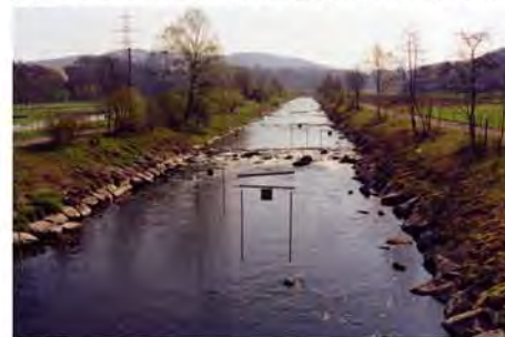
2: Kanalisiertes Gerinne mit Einheitsprofil. Empfohlene Massnahme: Gerinneverbreiterung durch Seitenerosion, Überprüfen Hochwasserschutz.
