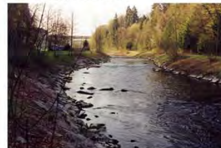
3: Kanalisiertes Gerinne mit harten Uferverbau. Empfohlene Massnahmen: Rückbau Uferschutz und Förderung Seitenerosion.
