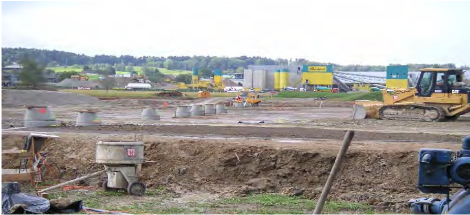
Retentionsfilterbecken Riedmatt im Bau: Planie der Beckensohle, Kontrollschächte des Drainagesystems.
