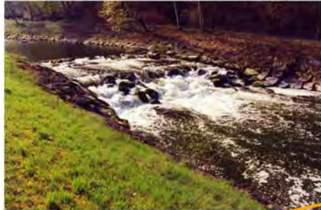
1: Steile Blockrampe verhindert den Fischaufstieg
