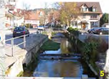
Kanalisiertes Gerinne mit Sohlwellen oberhalb des Durchlasses "Ochsenkreuz"
