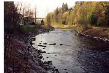
3: Kanalisiertes Gerinne mit harten Uferverbau. Empfohlene Massnahmen: Rückbau Uferschutz und Förderung Seitenerosion.
