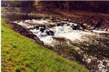
1: Steile Blockrampe verhindert den Fischaufstieg
