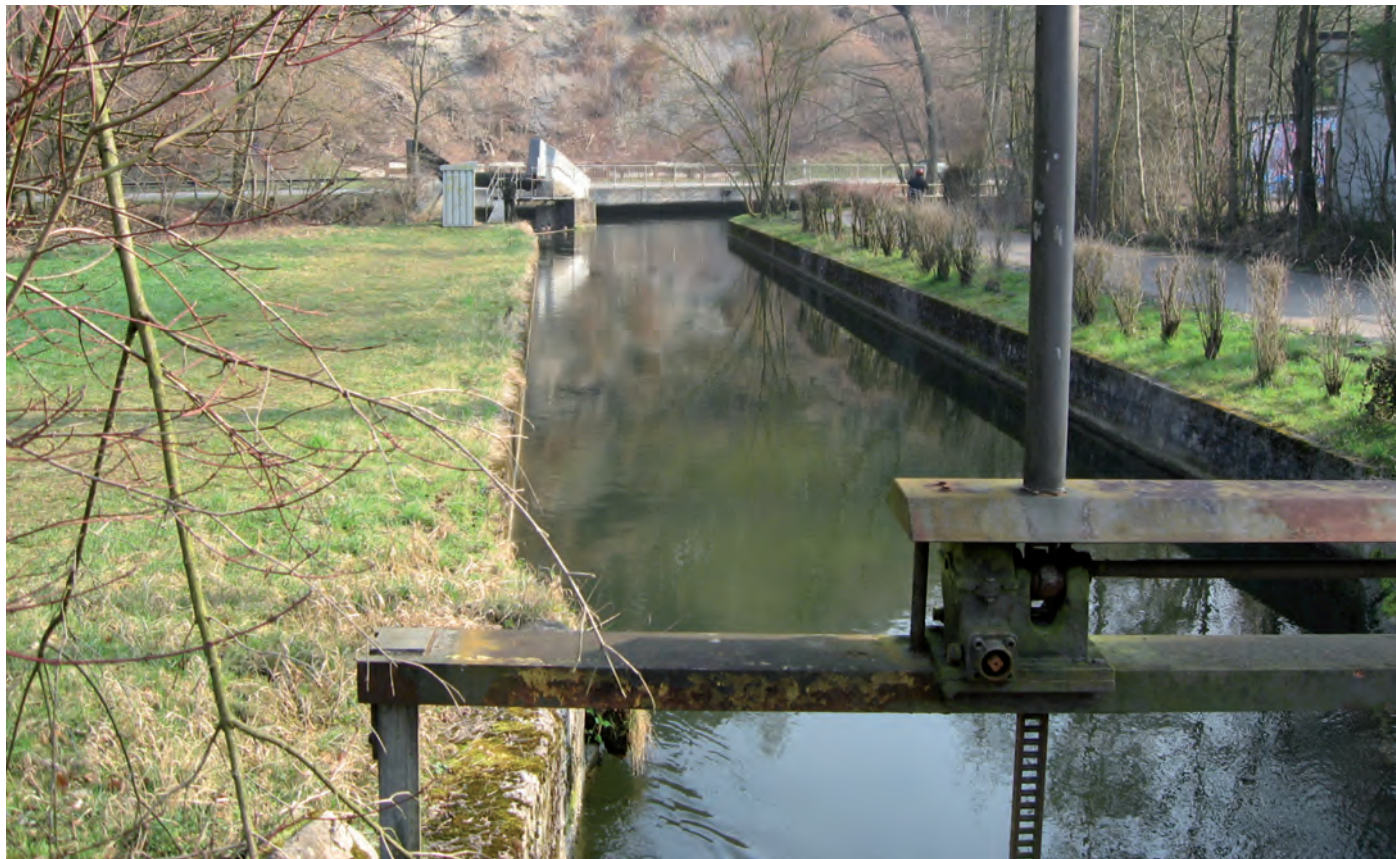
Historische Wasserkraftanlagen bei der ARA Seegräben
