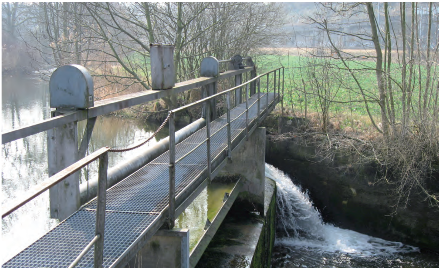
Wehr als Wanderhindernis für Fische
