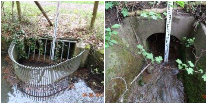
Bilder aus einer Fotodokumentation, links: Rechen, rechts: Einlauf
