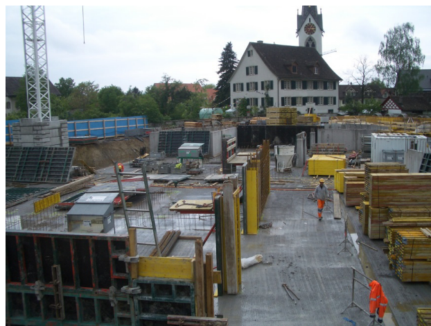
Bauarbeiten in vollem Gang
