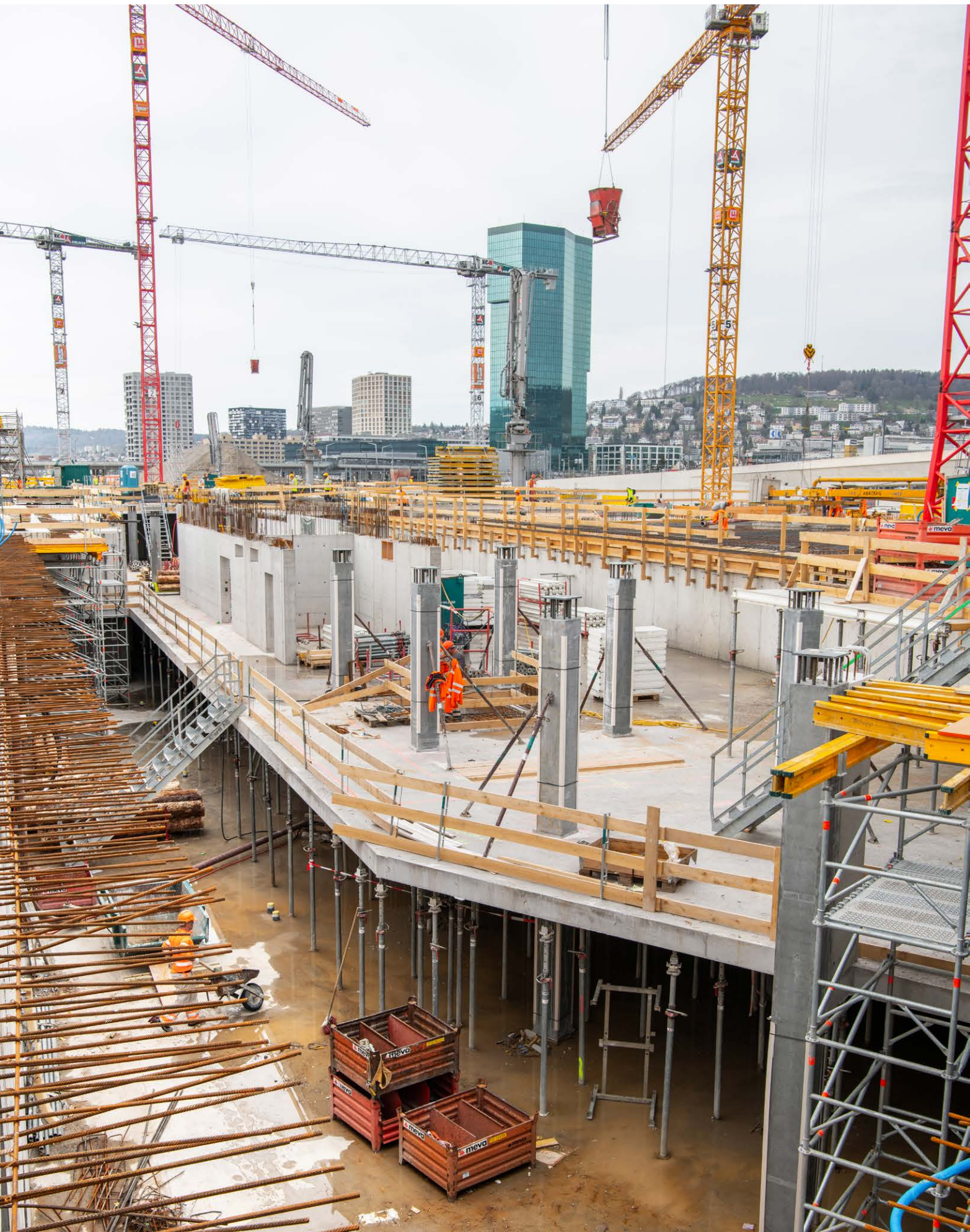
Die Arbeiten schreiten zügig voran.
