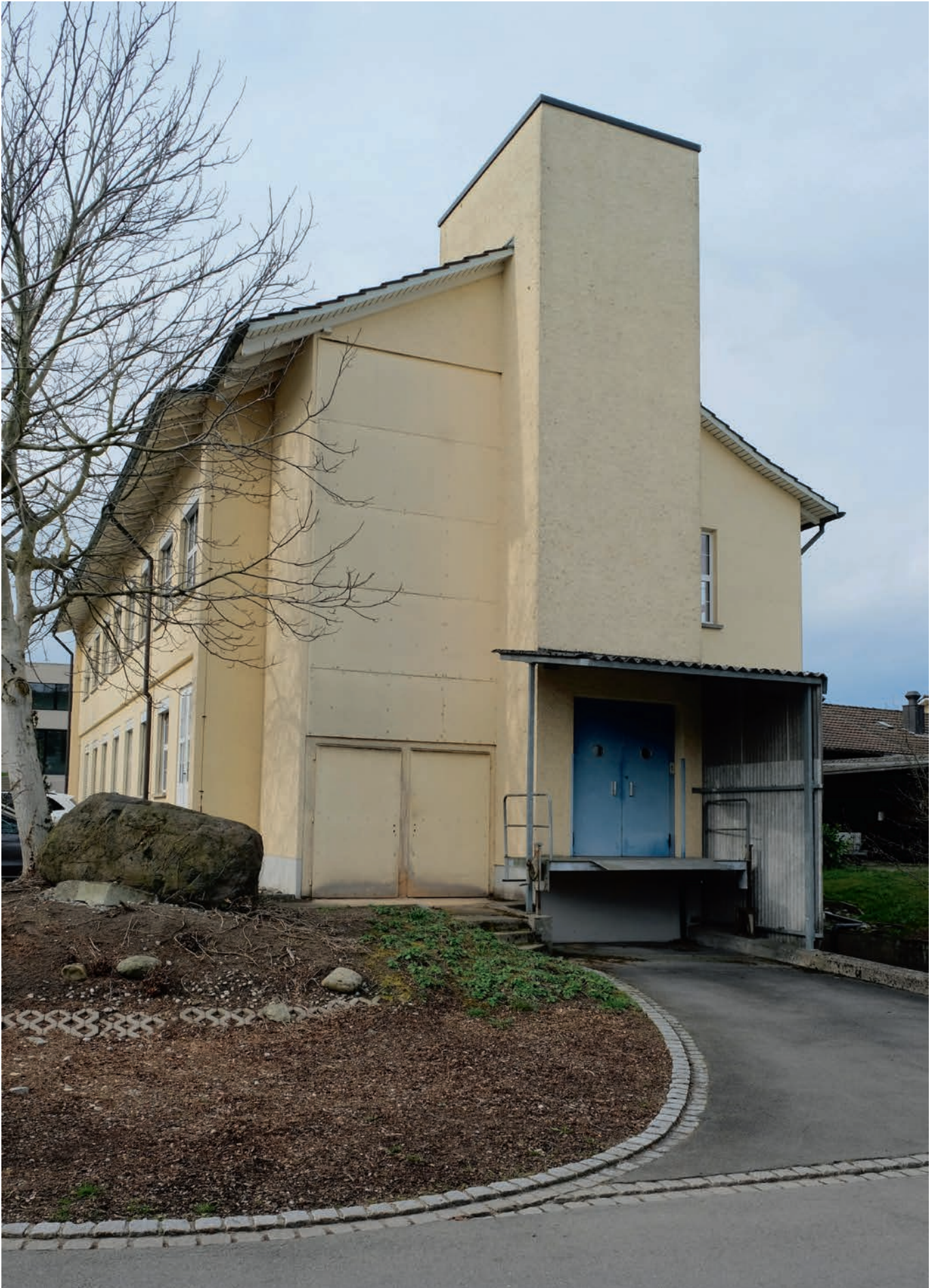
Nordfassade mit Anlieferung, Lift und Spähneabsauganlage (Bestand)
