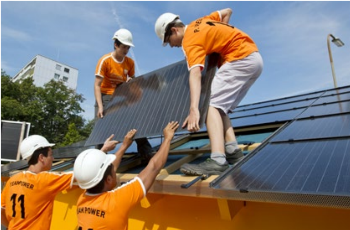
Eine vollintegrierte Photovoltaikanlage wird montiert (Bild: Meyer Burger AG)
