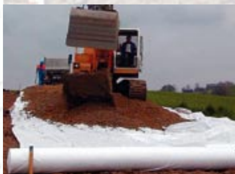
Bodenschonende Arbeitstechnik: z.B. die fachgerechte Schüttung einer temporären Transportpiste.
