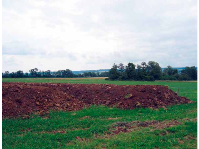
Zwischenlager von Ober- und Unterboden.
