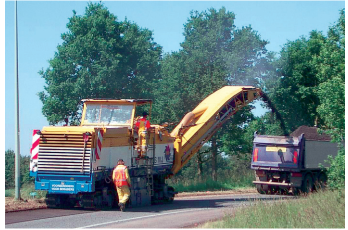
Abb. 4: Absaugung der Stäube aus dem Fräsraum und Ausblasen an der Abwurfstelle am Förderband
