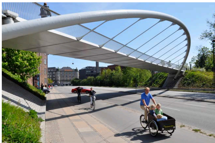
Auf der Brücke: Velobahn auf Eigentrassee (Zweirichtungsverkehr). Unter der Brücke: Hauptverbindung auf Einrichtungsweg (Kopenhagen, DK)
