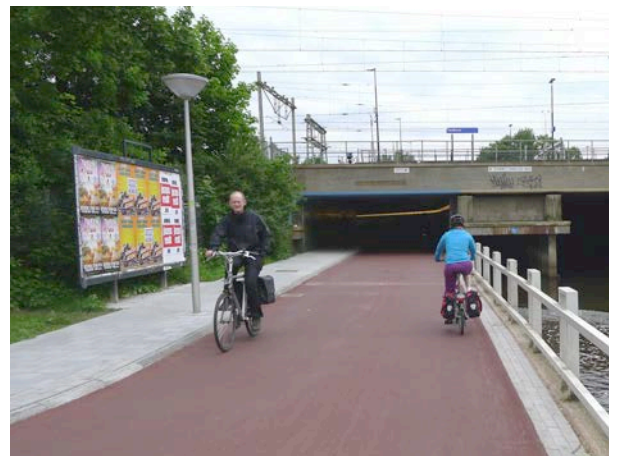
Getrennte Führung Fuss- und Veloverkehr in Unterführung (NL)
