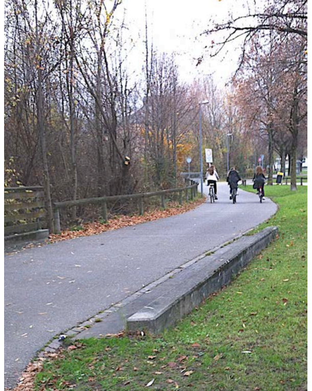
Ausreichende Breite ermöglicht das Nebeneinanderfahren (Burgdorf, CH)
