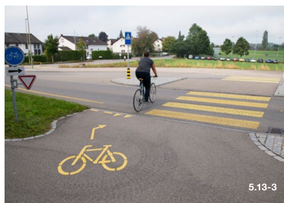
Querungshilfe mit einem geschützten Mittelbereich in Kombination mit einer Fussgängerquerung. Alte Winterthurerstrasse, Nürensdorf.
