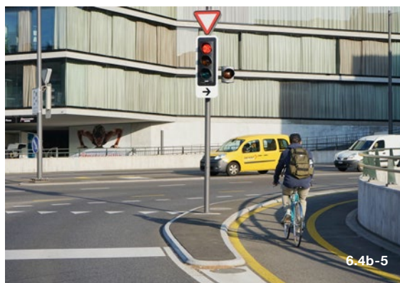
Ampelumfahrung mit einem Bypass an der Mellingerstrasse in Baden
