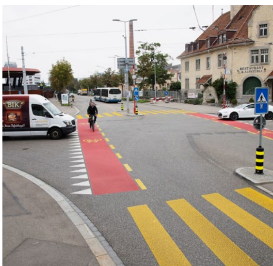
Radstreifen mit roter Einfärbung im Konfliktbereich bei der Einmündung Bullingerstrasse in Zürich 5.3-3
