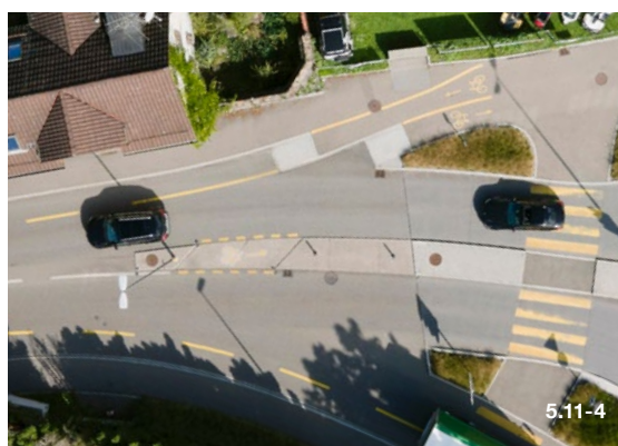
Rückführung und Zufahrt eines Radwegs auf die Rapperswilerstrasse in Wetzikon. Um auf den Radweg zu gelangen, können Velofahrende die Strasse in zwei Etappen queren.
