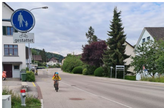
Aufgrund des Schutzbedürfnisses ist hier das Trottoir an der Reppischtalstrasse in Stallikon für den Veloverkehr freigegeben.
