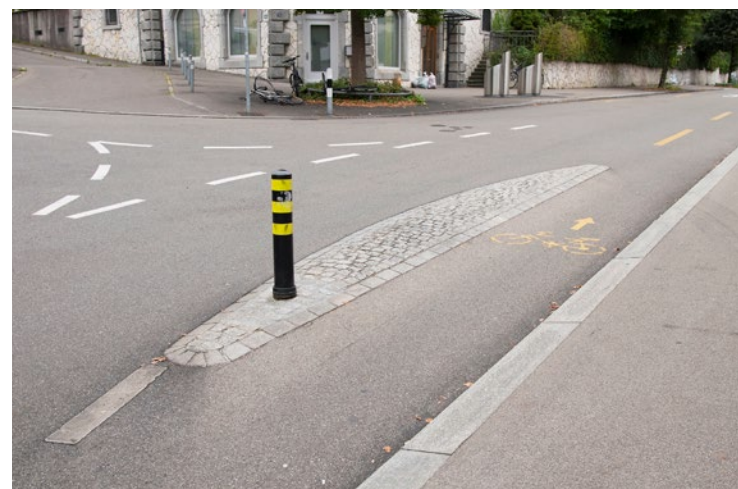
Velofreundliche Verkehrsberuhigungsmassnahmen bei einem Knoten mit Rechtsvortritt an der Sonneggstrasse in Zürich
