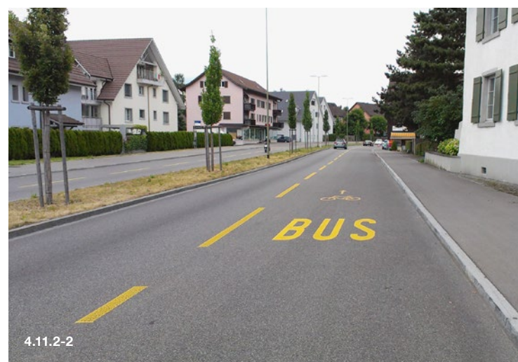
Velos auf der Busspur auf der Usterstrasse in Volketswil. Aufgrund der geringen Längsneigung und der Raumsynergie stellt dies hier eine praktikable Lösung dar.
