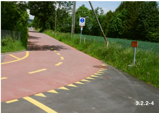
Test mit rötlichem Belag am Grünaueweg in Winterthur, kombinierter Fuss- und Veloweg
