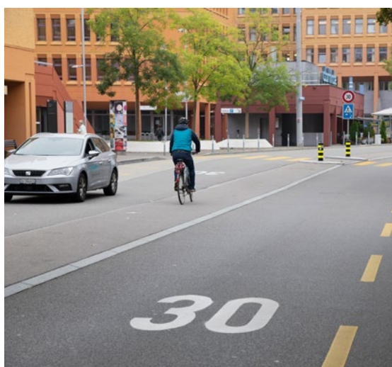
Geschützte und baulich abgesetzte Abbiegehilfe für den Veloverkehr auf der Schwamendingenstrasse in Zürich
