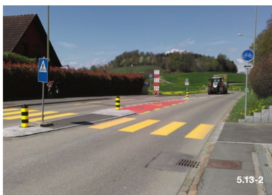
Geschützte Querungshilfe für den Veloverkehr, um auf den Radweg zu gelangen. Uttenbergstrasse, Knonau.
