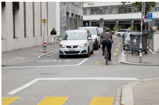
Einbahnstrassen mit Velogegeverkehr ermöglichen das Schliessen von Netzlücken und direkte Verbindungen. Beginn und Ende sollen mit einer Markierung und Signalisation erkennbar gemacht werden. Grüngasse/Ankerstrasse, Zürich.
