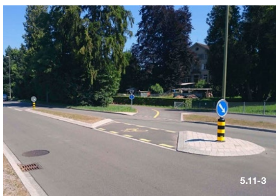
Rückführung des Veloverkehrs auf die Strasse. Rütistrasse, Dürnten.
