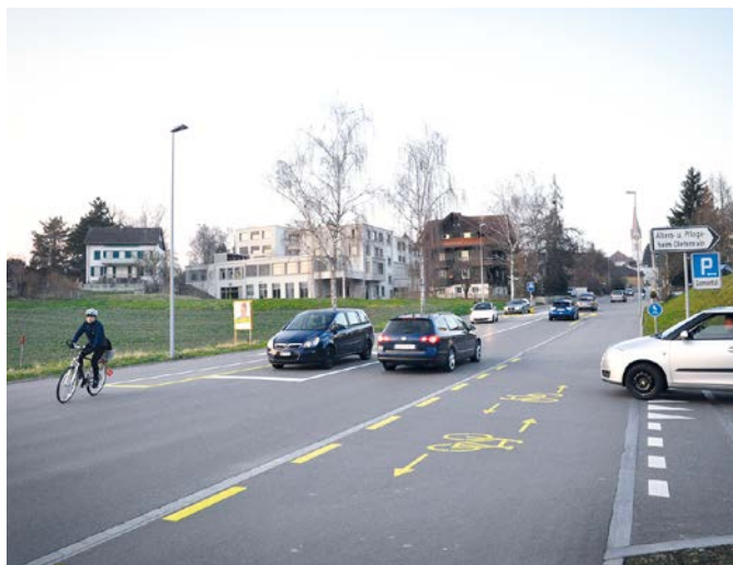
Zweirichtungsbahnweg; der Linksabbiegestreifen auf der Kantonsstrasse hilft, diesen zu erreichen (Uster)
