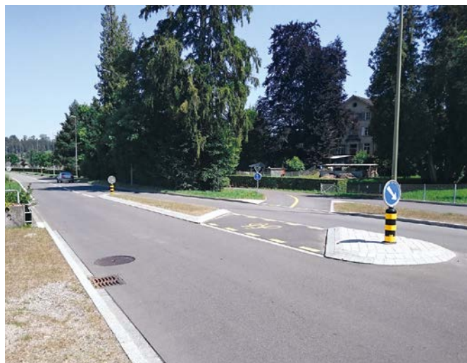
Gesicherte Führung des Rad-/Gehwegs in die innerörtliche Mischverkehrssituation (Ortseingang Dürnten)
