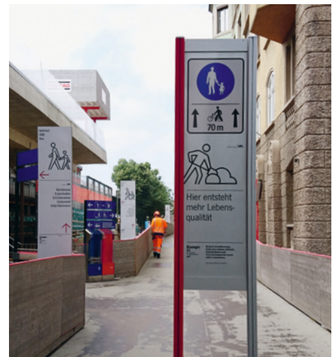
Die Veloroute bleibt durchgängig, auf 20m muss das Velo geschoben werden (Rudolfstrasse Winterthur).
