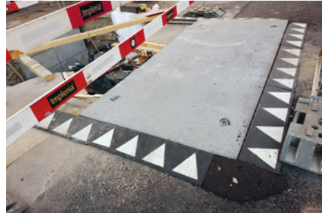
Vorfabrizierte Anrampungen aus Kunststoff sind flexibel und vielseitig einsetzbar (Beispiel aus Basel).
