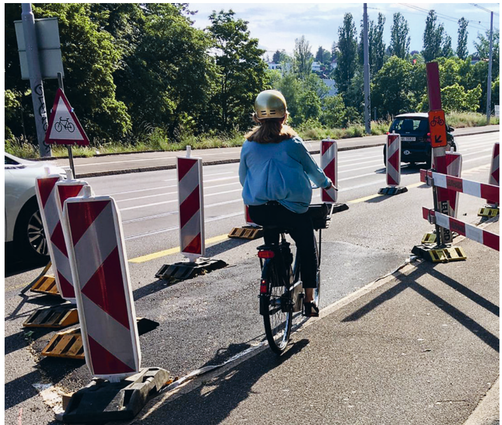
Der Veloverkehr wird sicher abseits vom motorisierten Verkehr durch die Baustelle geführt (Dorenbachviadukt Basel).
