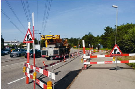
Absatz mit einer korrekt ausgeführten temporären Asphalt-Anrampung (Industriestrasse Volketswil).
