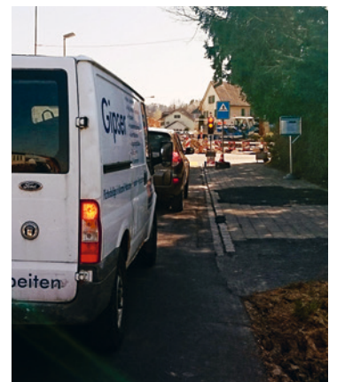
Bei Lichtsignalanlagen sollen Velos vorfahren können, sonst wird die Grünphase knapp für eine sichere Durchfahrt (Stationsstrasse Rickenbach).
