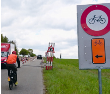
Hier ist die Durchfahrt für den MIV erlaubt. Für den Veloverkehr wäre eine Umleitung ohne Verbot oft sinnvoller (Witikonerstrasse Zürich).
