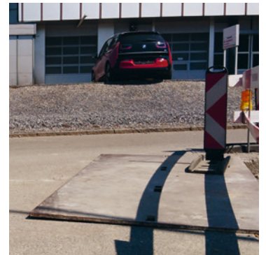
Scharfkantige Stahlplatten bilden ein Sicherheitsrisiko und sind auch bei kurzen Baustellen zu vermeiden (Zürichstrasse Wetzikon).
