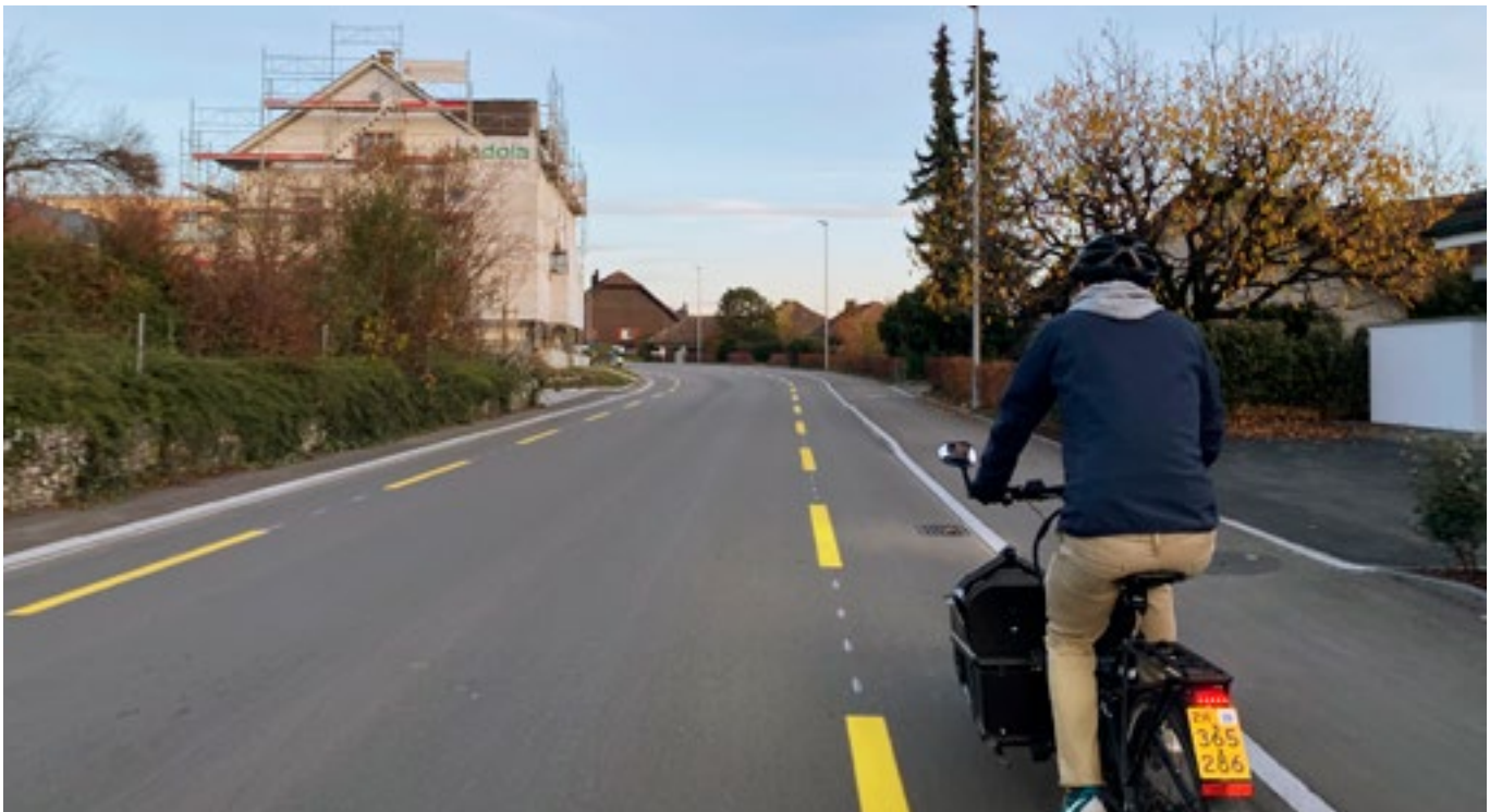
Frisch markierter Radstreifen auf der Aufdorfstrasse in Männedorf
