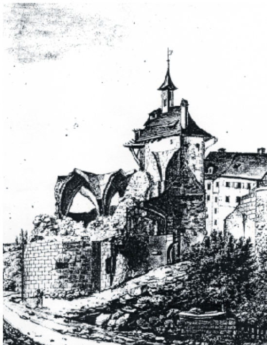
Abbruch des Rennwegtors. 37
