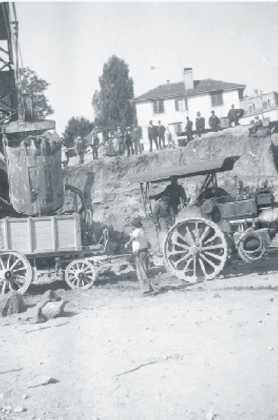
Oben: Bagger an der Clausiusstrasse in Zürich, 1911. 91
