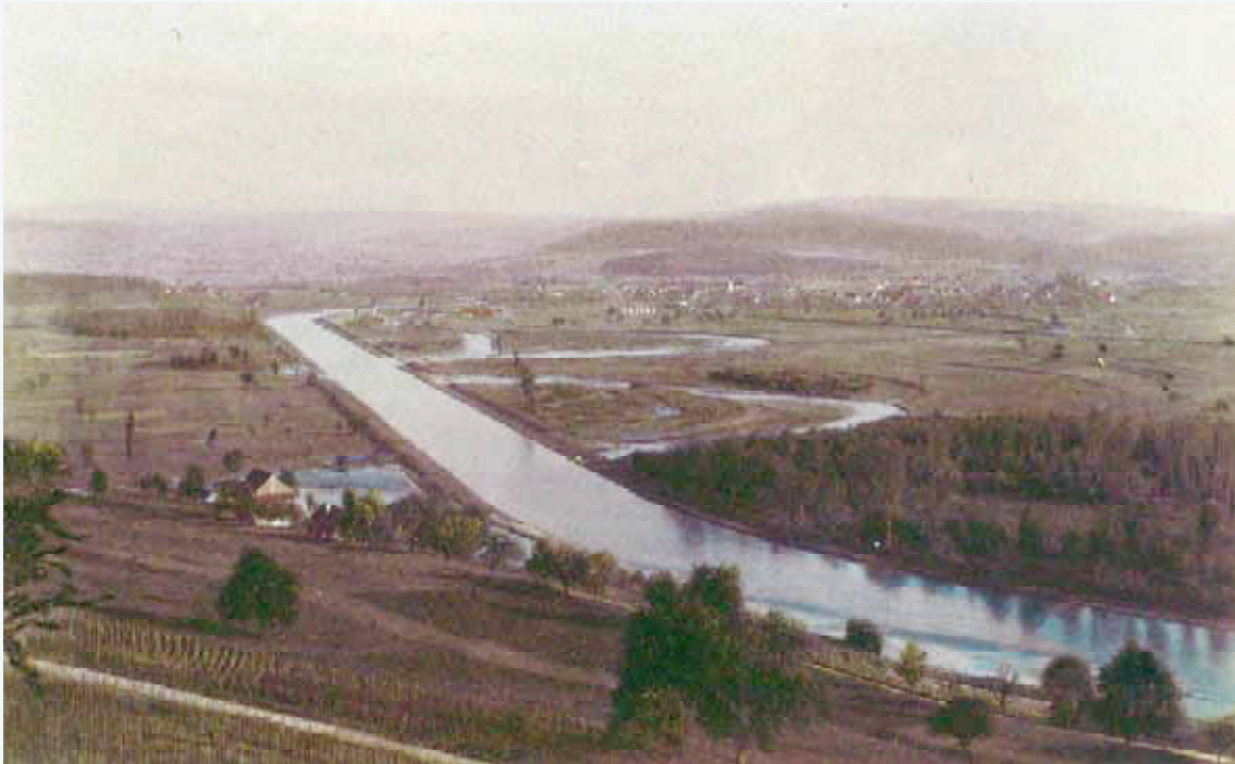
Limmatdurchstich bei Oetwil (Flussbegradigung), 1888. 68
