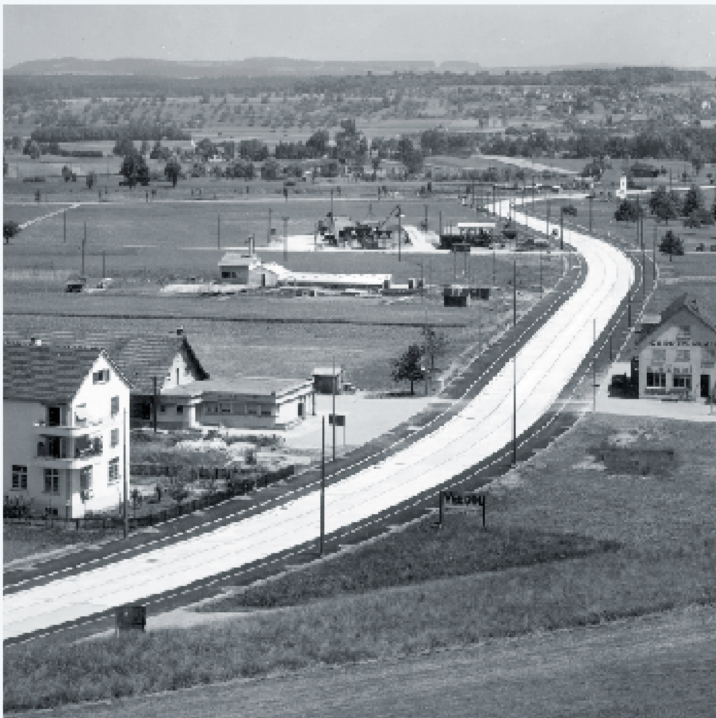
Erste Betonstrasse des Kantons Zürich, Überlandstrasse, 1937. 101
