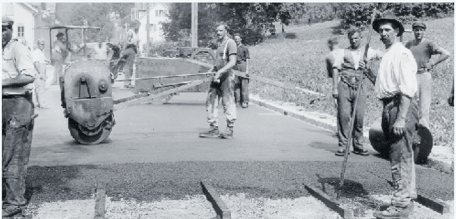
Unten: Handwalze mit Motor, Belageinbau Strasse Wald-Rüti, 1932. 95
