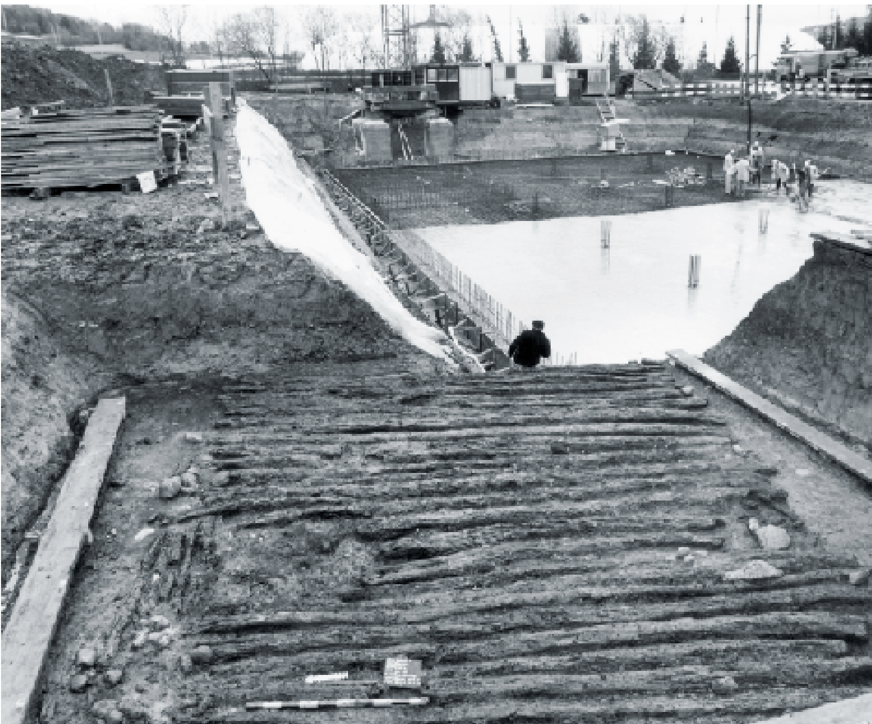
Querschnitt durch eine Römerstrasse bei Otelfingen. Bei sumpfigem Gelände wurden junge Baumstämme ausgelegt. 1
