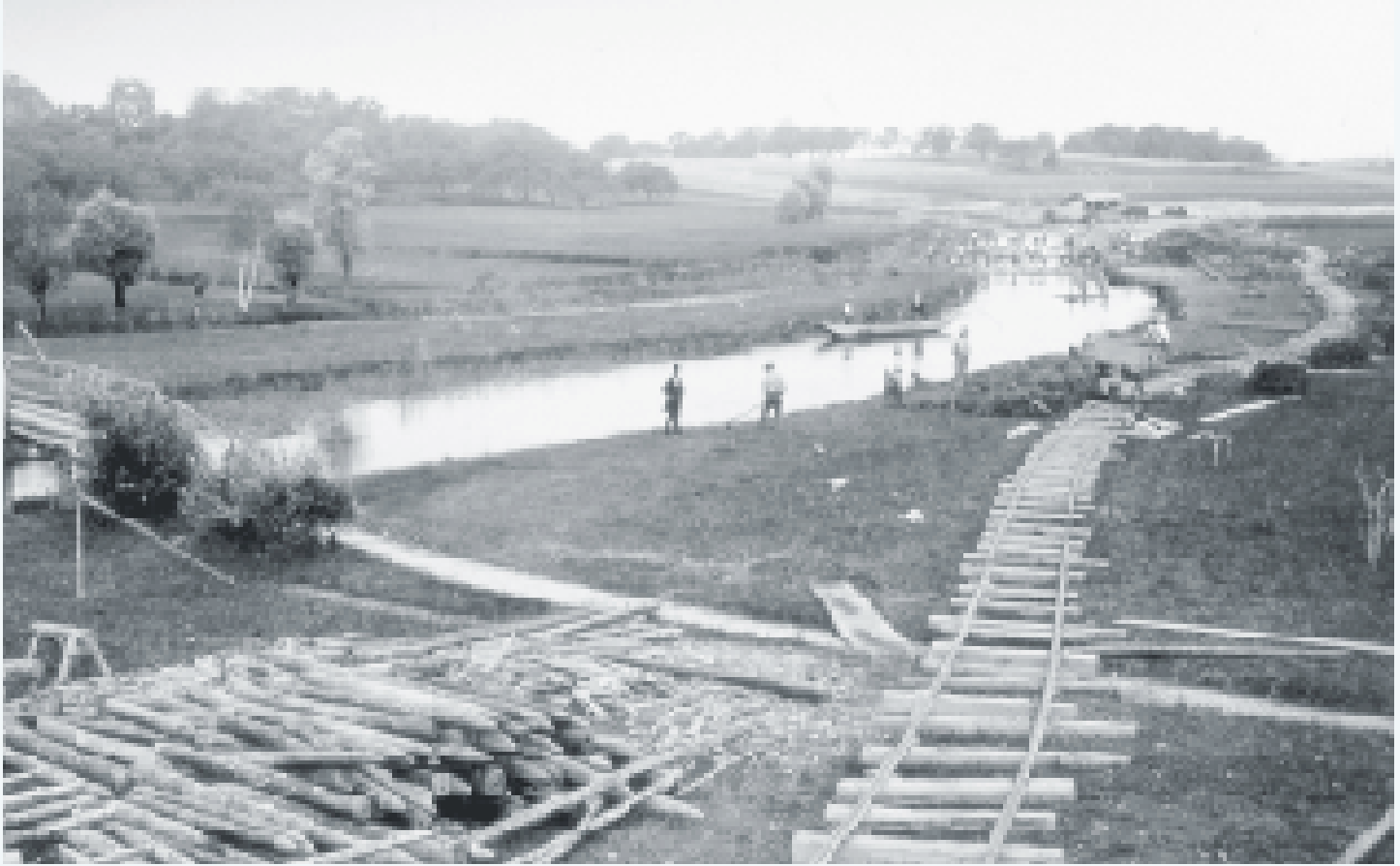
Glattkorrektur, Holzpfähle und Feldbahn im Oberhauserried, 1895. 70
