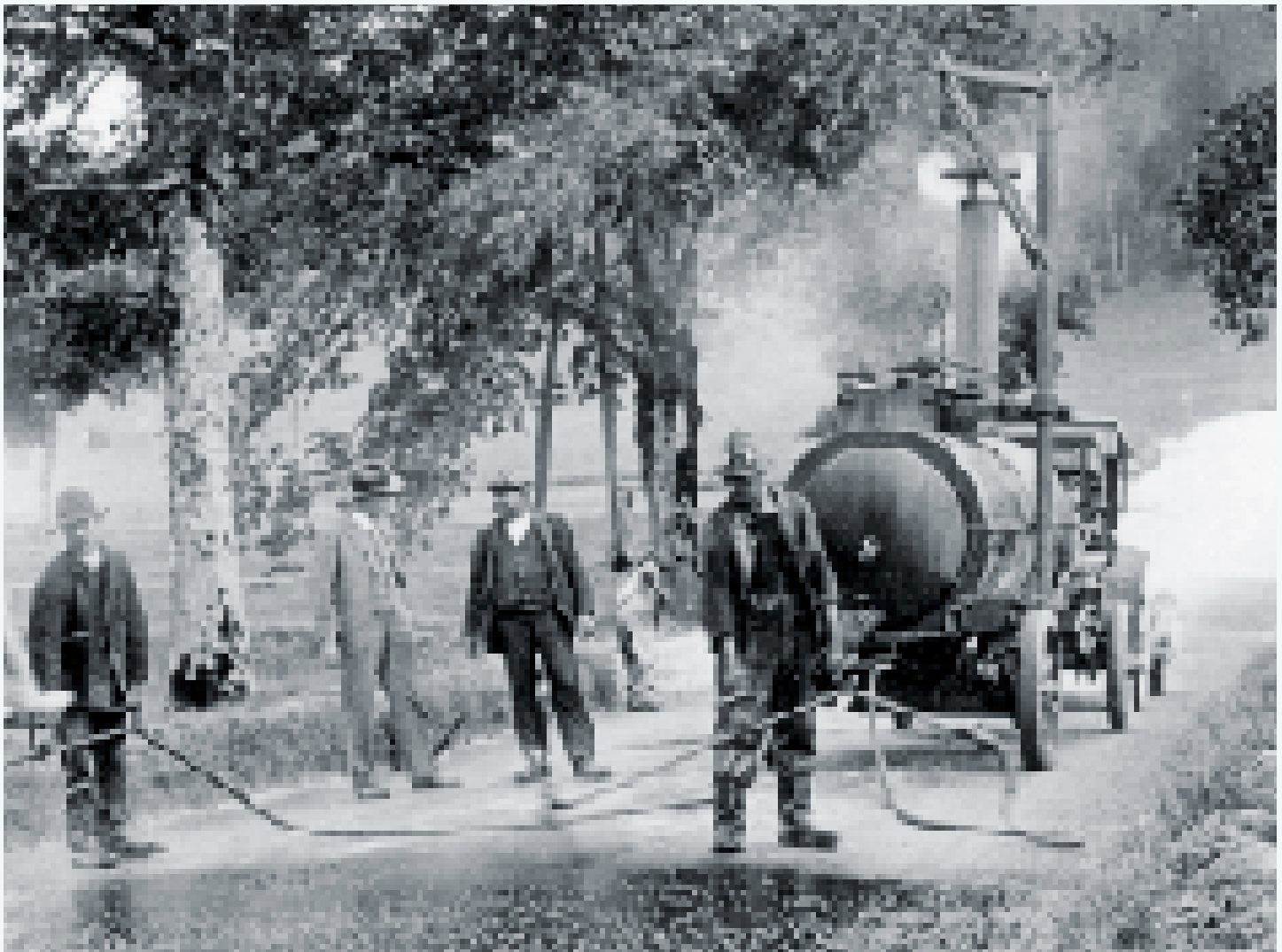
Asphalt wird auf eine bereits bestehende Strasse aufgespritzt, um 1920. 96
