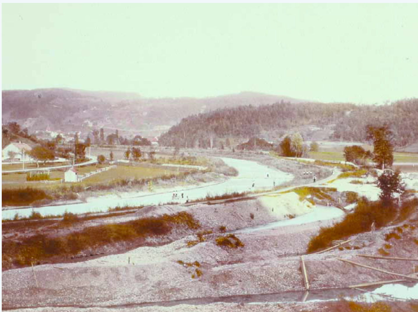
Tösskorrektur bei Rikon, Bau von Dämmen und Höherlegung der Flusssohle, um 1890. 61
