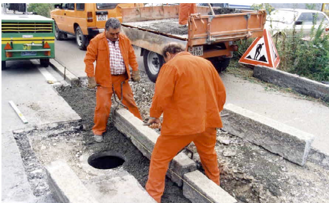
Korrektur von Bord- und Wassersteinen an der Überlandstrasse in Dietikon, 1994. 135
