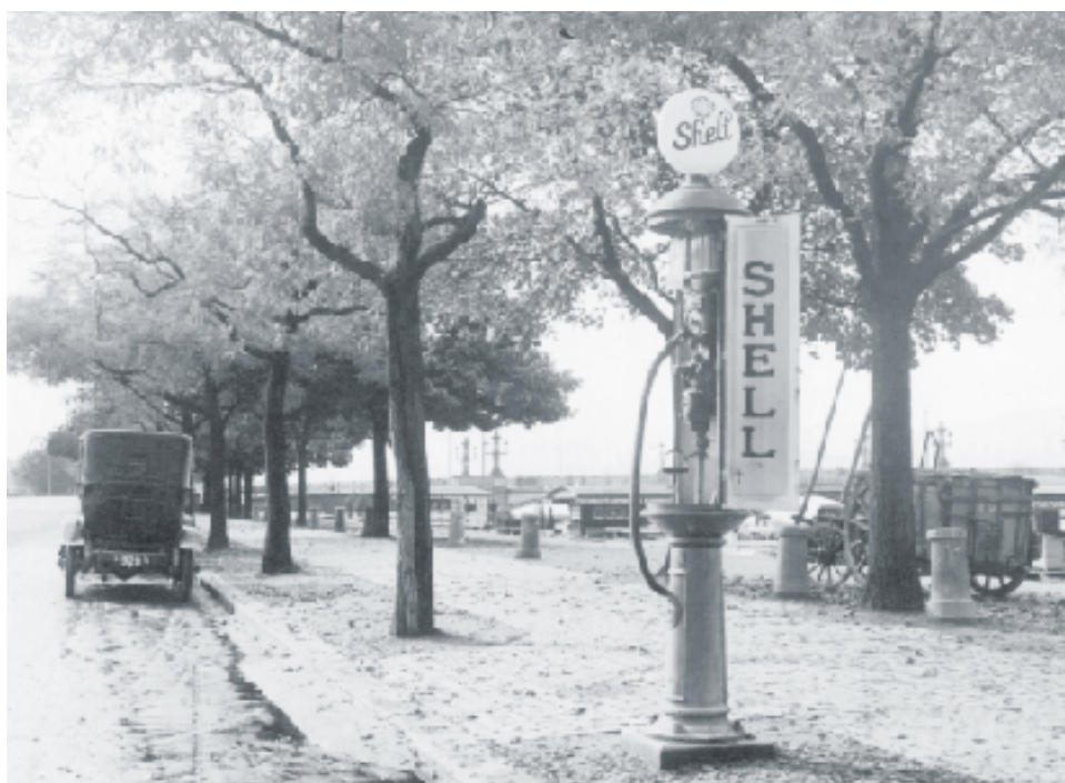
Benzinabfüllstelle am Utoquai, 1925. 86
