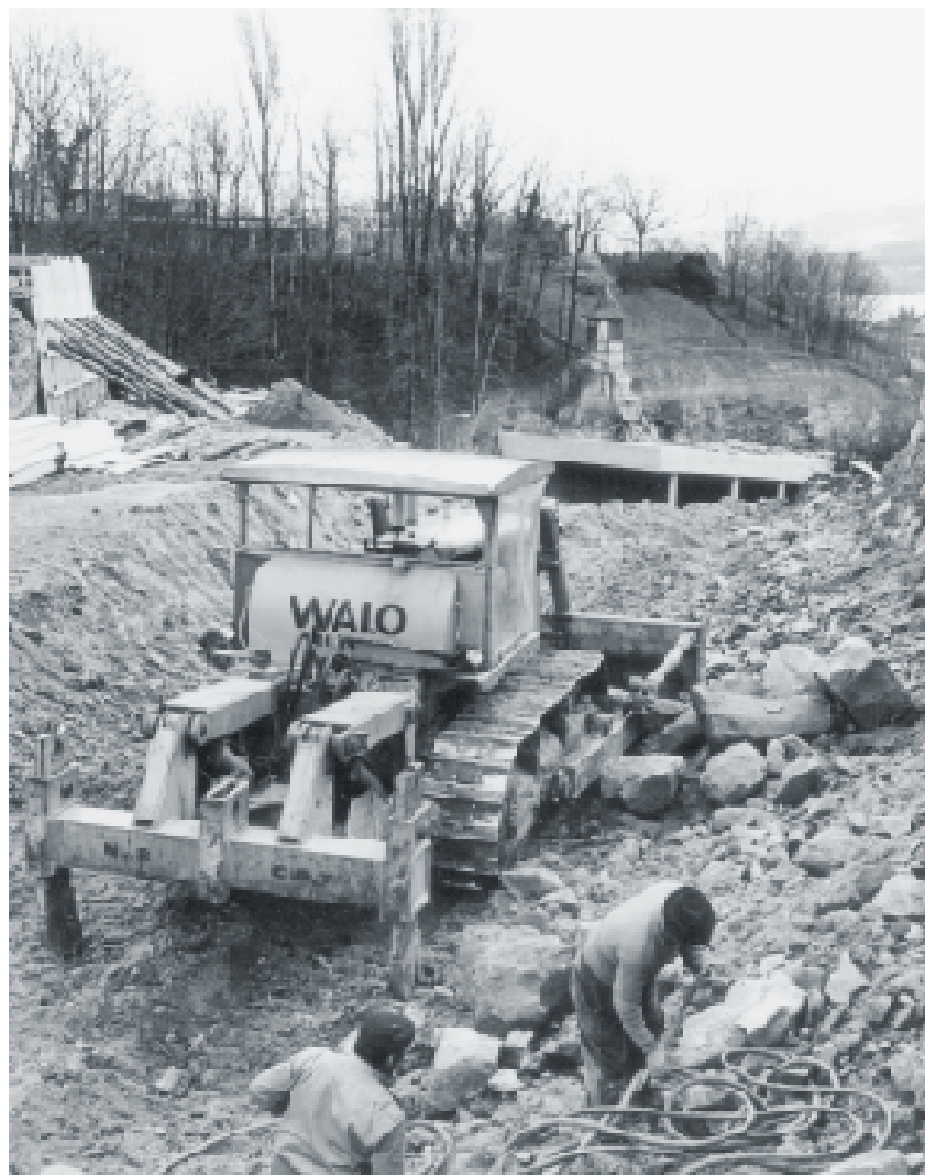
Bau einer Strassenunterführung bei Herrliberg, 1968. 118
