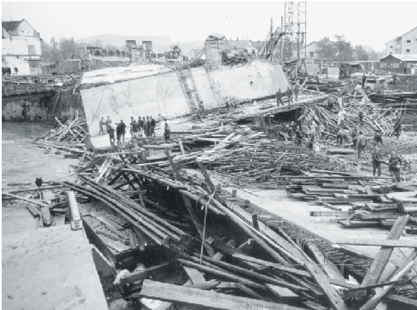
Das eingebrochene Leengerüst der Autobahnbrücke über die Töss bei Winterthur-Wülflingen, 1966. 114
