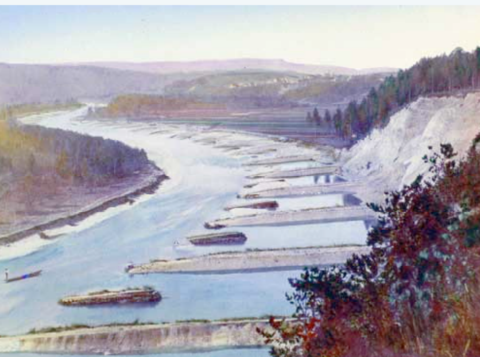
Links: Thurkorrektur bei Andelfingen mit Buhnen, 1882. 71
